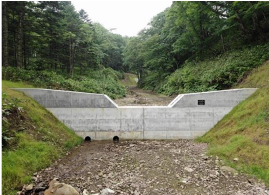
コンクリート床固工
