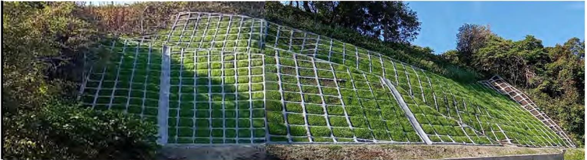
コンクリート簡易法枠工
