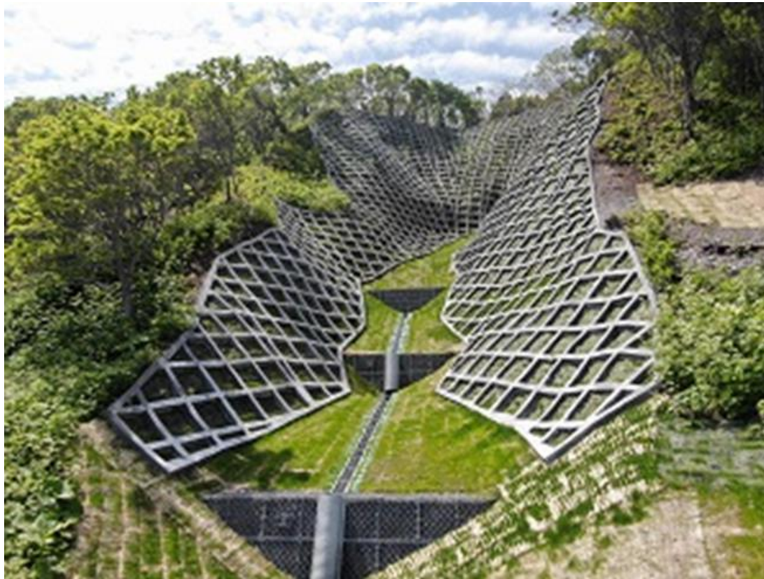
鋼製土留工、コンクリート法枠工
