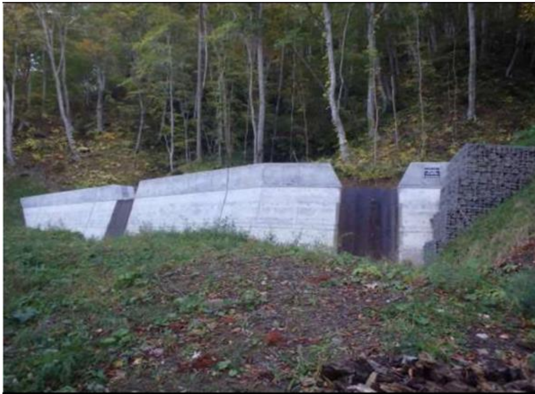
コンクリート床固工
