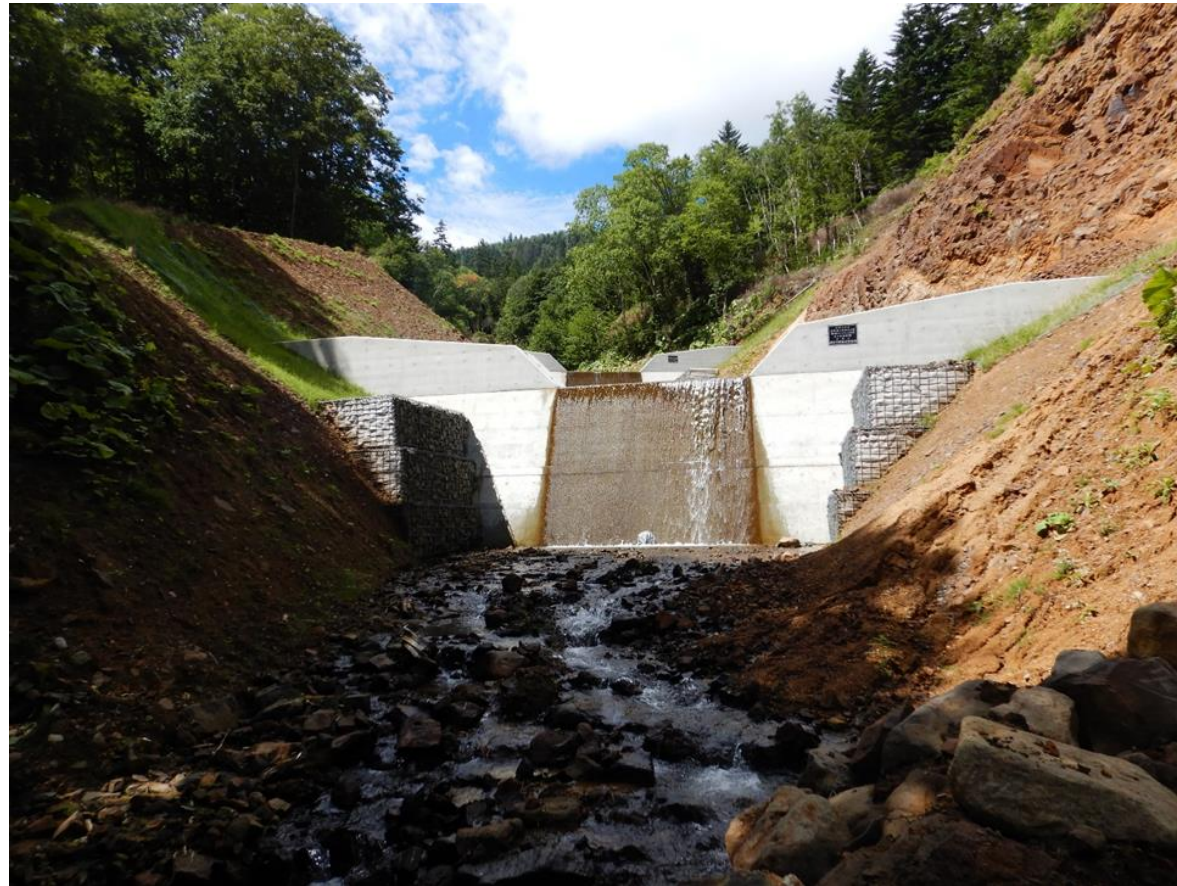
コンクリート床固工
