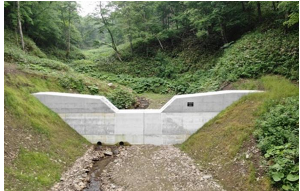
コンクリート谷止工
