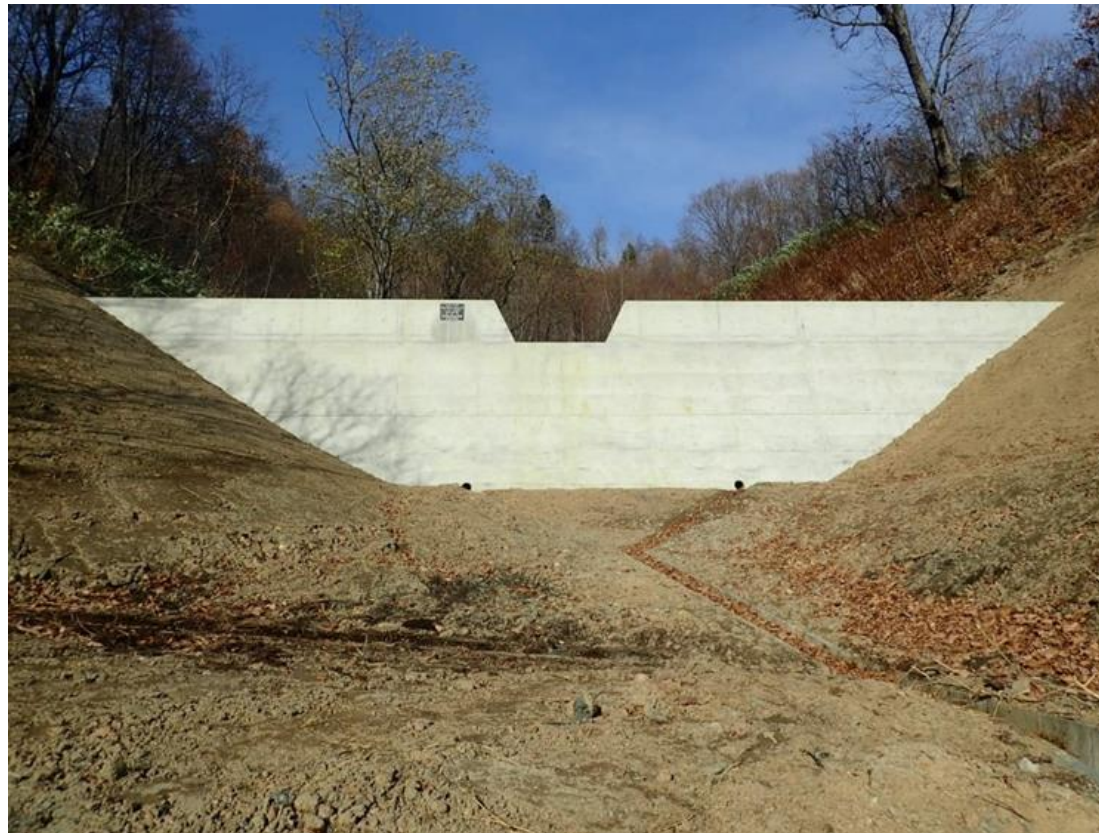
コンクリート床固工
