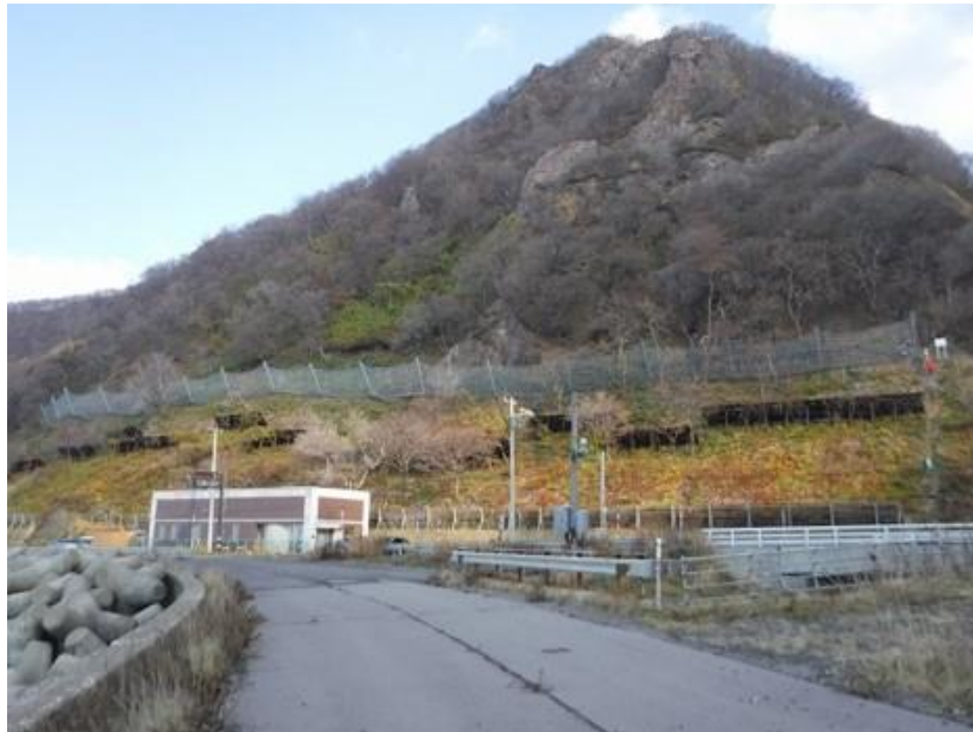
落石防護柵工
