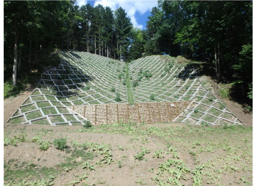
木製校倉式土留工 木製軽量法枠工
