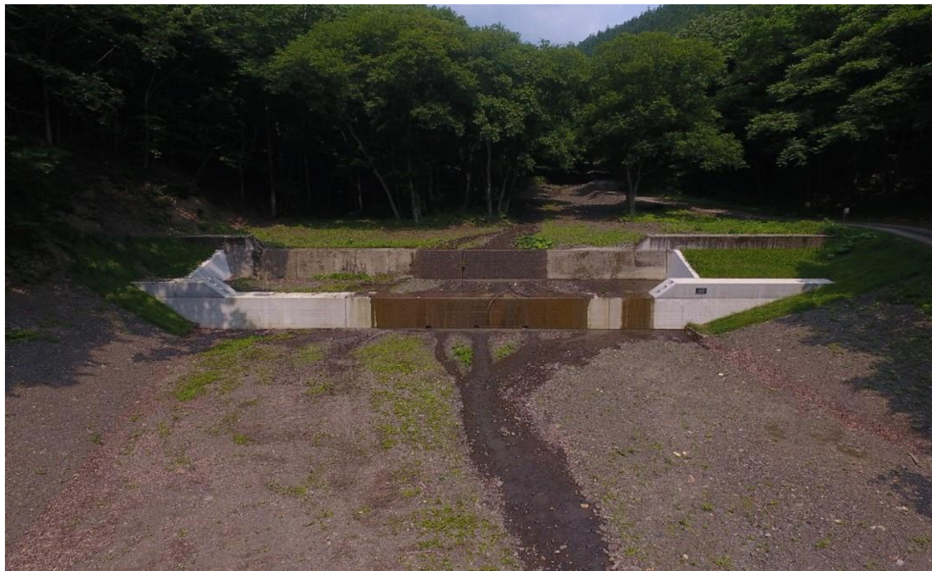
コンクリート床固工
