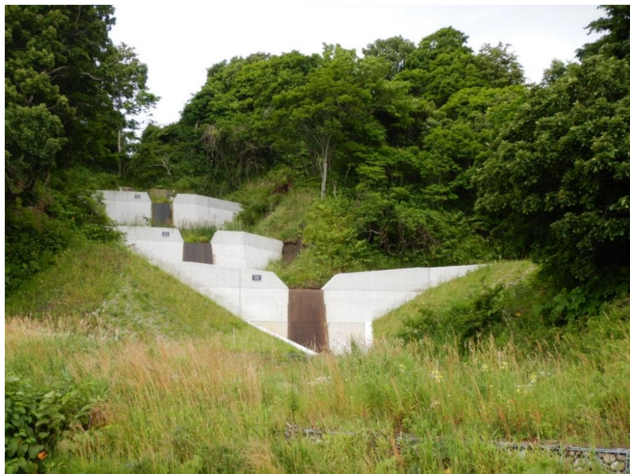
コンクリート谷止工
