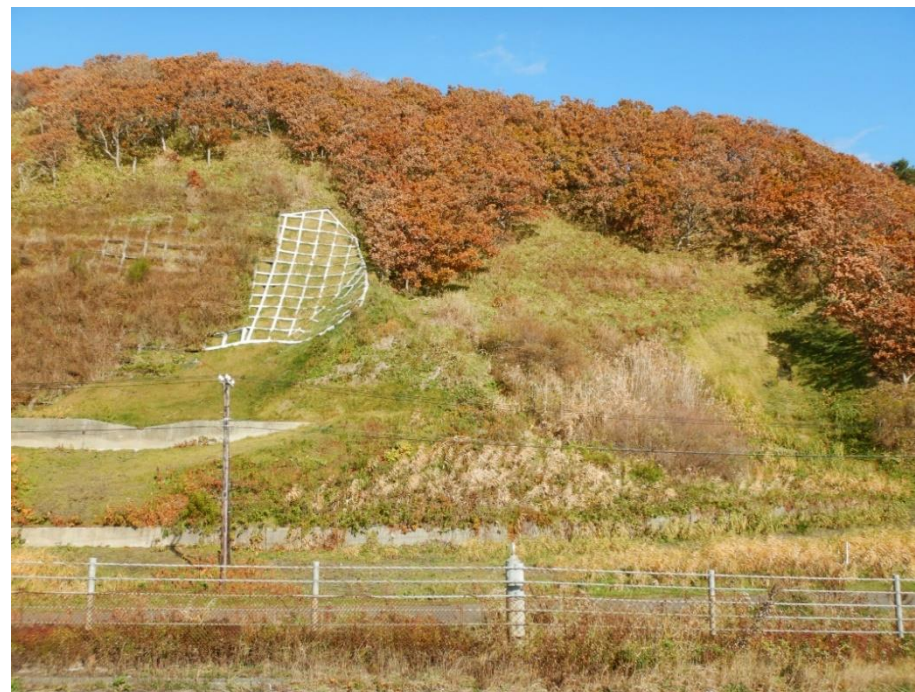
コンクリート法枠工
