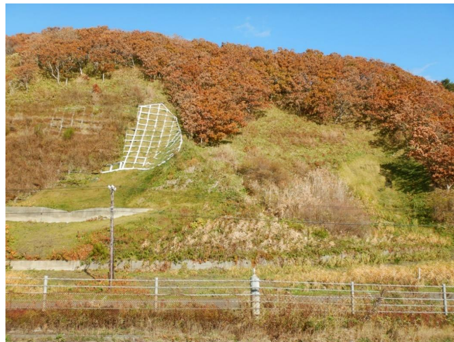
コンクリート法枠工
