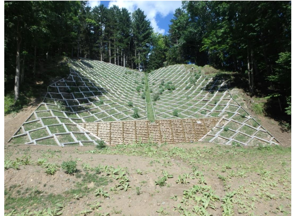
木製校倉式土留工 木製軽量法枠工
