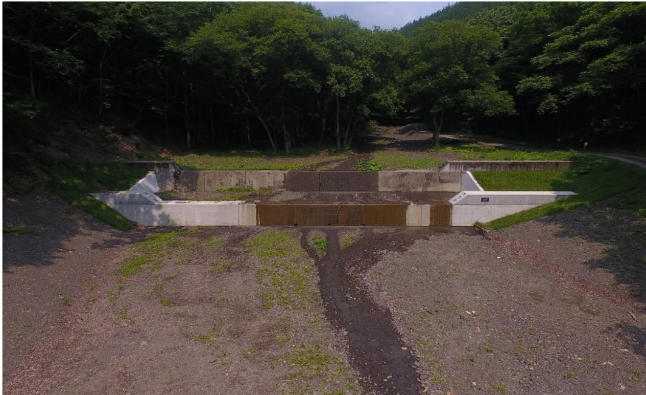
コンクリート床固工
