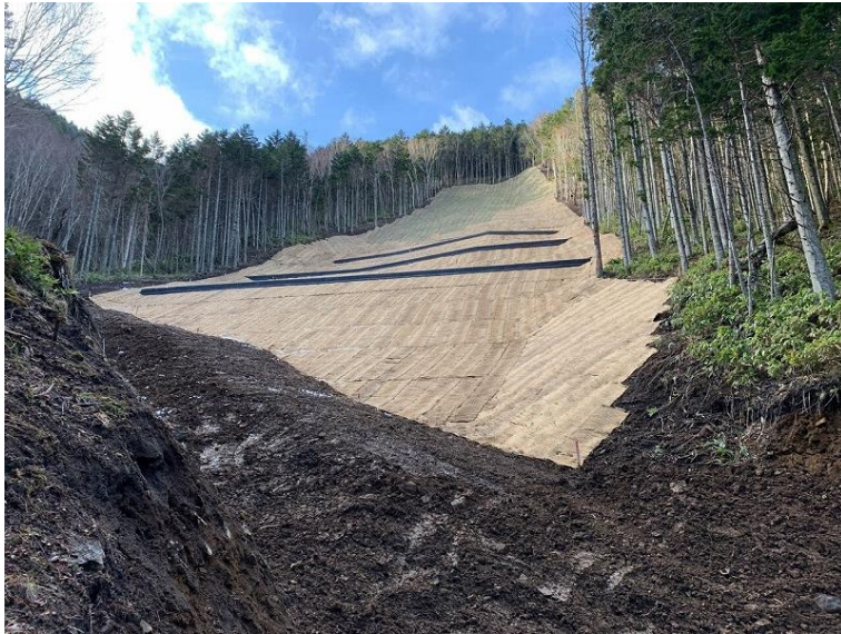
紋別川治山工事
