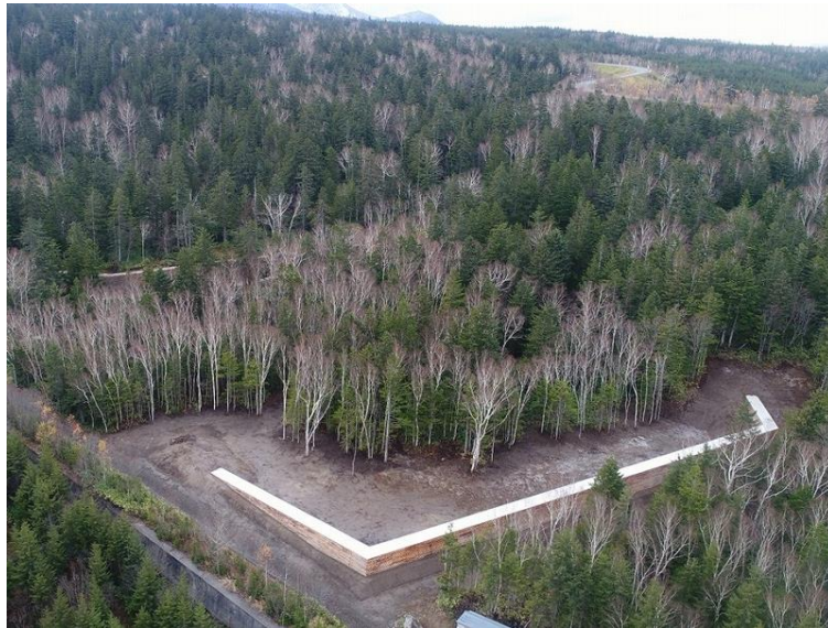
十勝岳治山工事その1 北海道美瑛町
