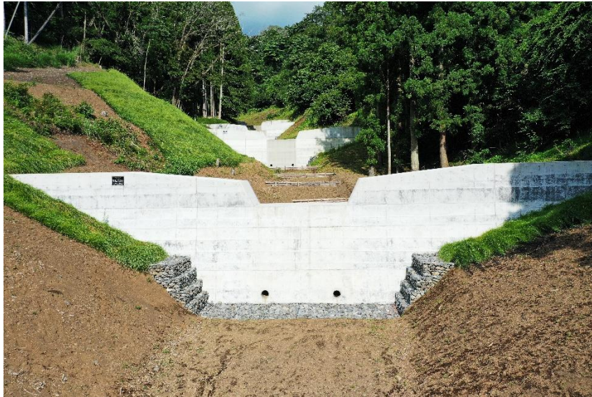
小山地区（奥の沢川 1 外）直轄治山工事 静岡県小山町
