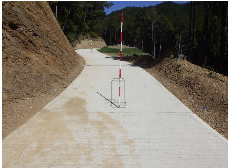
福連木 321-1 林道及び福連木 321-2 林道新設工事
