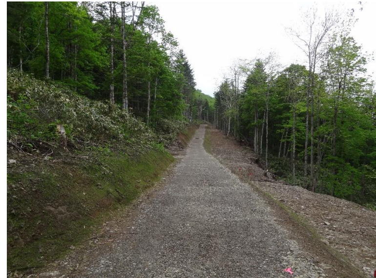
松山1号林道（林業専用道）新設工事及び岩山林道（林業専用道）改良工事 北海道美瑛町 新谷建設(株)
