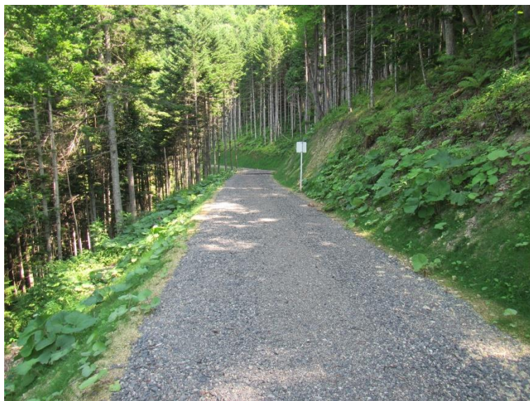
湯の沢支線林道（林業専用道）新設工事 北海道北見市 鐘ヶ江建設（株）
