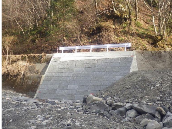
藪原林道災害復旧工事
