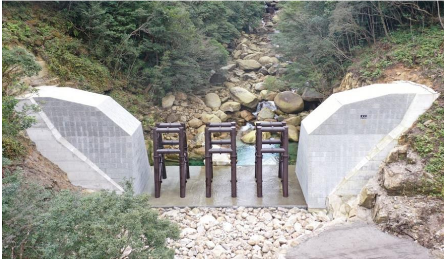
太忠岳 77 治山工事（関連災） 〈林道工事〉
