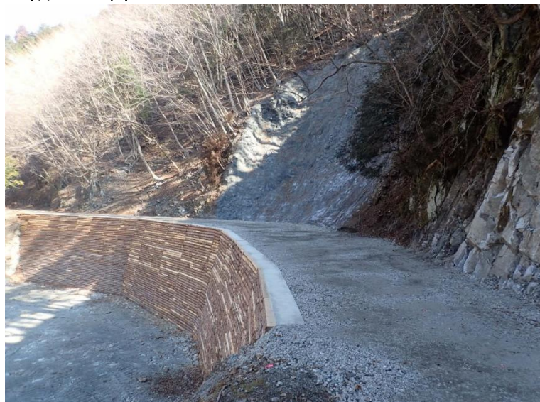
大又沢林道災害復旧工事 神奈川県足柄上郡山北町
