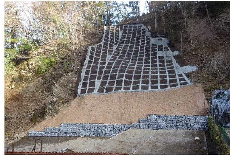
長野川地区復旧治山工事 静岡県伊豆市 小野建設（株）
