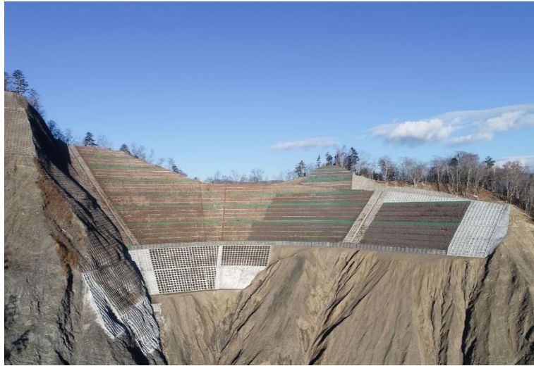
大井川地区（ホーキ薙）直轄治山工事 静岡県榛原郡川根本町 河津建設（株）
