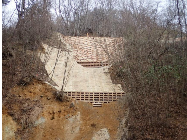
相倉地区復旧治山工事 群馬県吾妻郡中之条町
