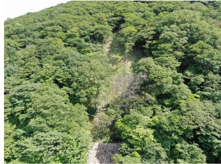
鍋割地区復旧治山工事 群馬県前橋市
