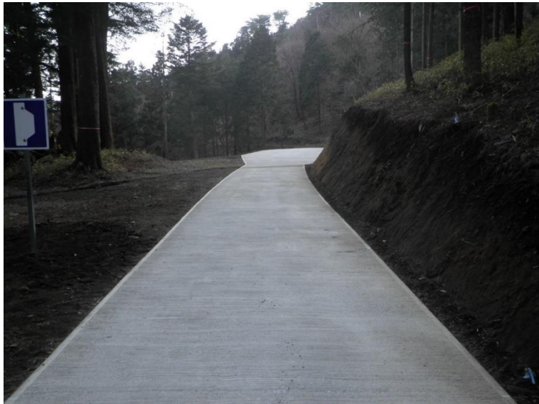
梨木内野作業道新設工事 群馬県桐生市
