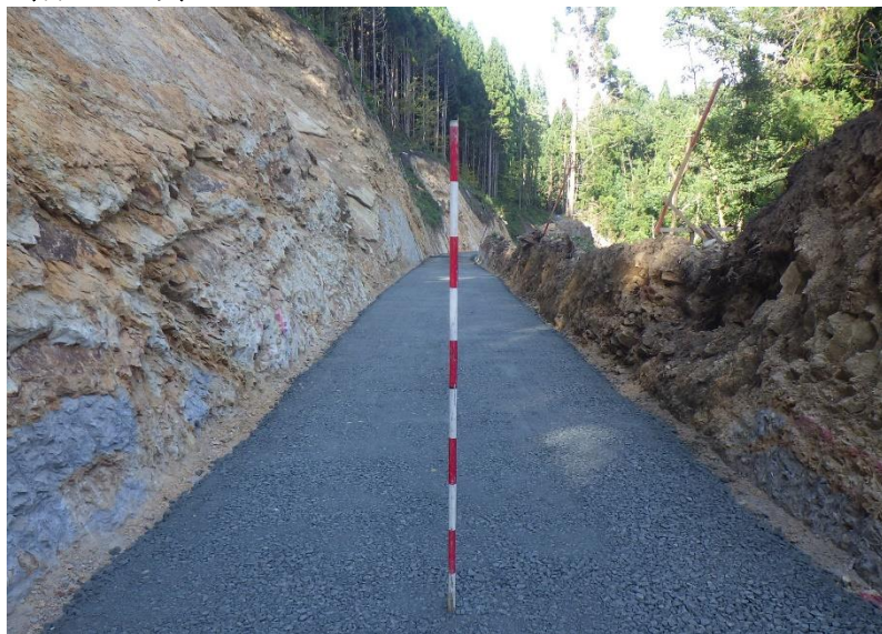
松沢林道（林道専用道）新設工事2 秋田県秋田市
