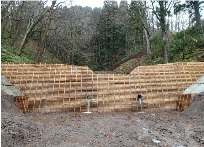
峠の沢治山工事 秋田県湯沢市 〈林道工事〉
