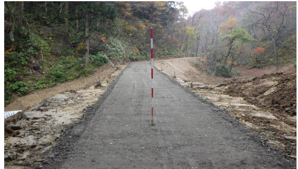
倉手沢林道改良工事 山形県最上郡戸沢村
