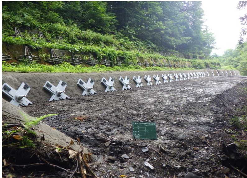
白糸沢地すべり防止工事 秋田県秋田市
