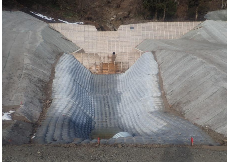
暖日山治山・林道災害復旧工事 山形県西村山郡朝日町
