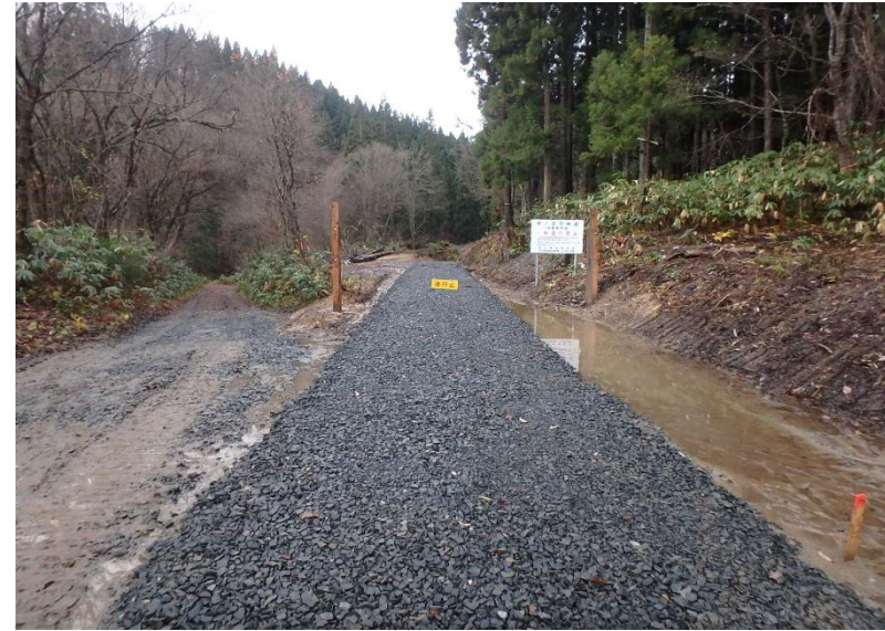
市ノ又沢林道（林業専用道）新設工事 秋田県北秋田市
