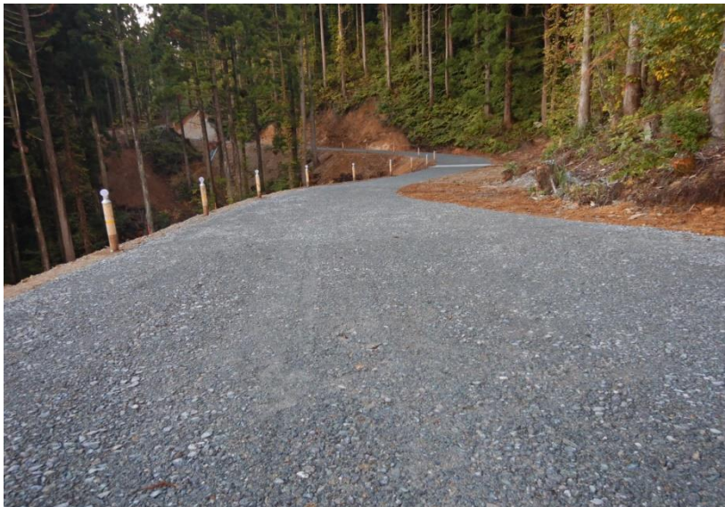
大水端沢林道（林業専用道）新設工事 秋田県仙北市
