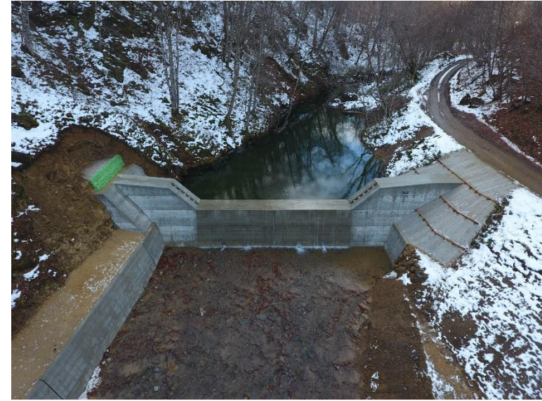
マダラ沢治山工事 宮城県栗原市
