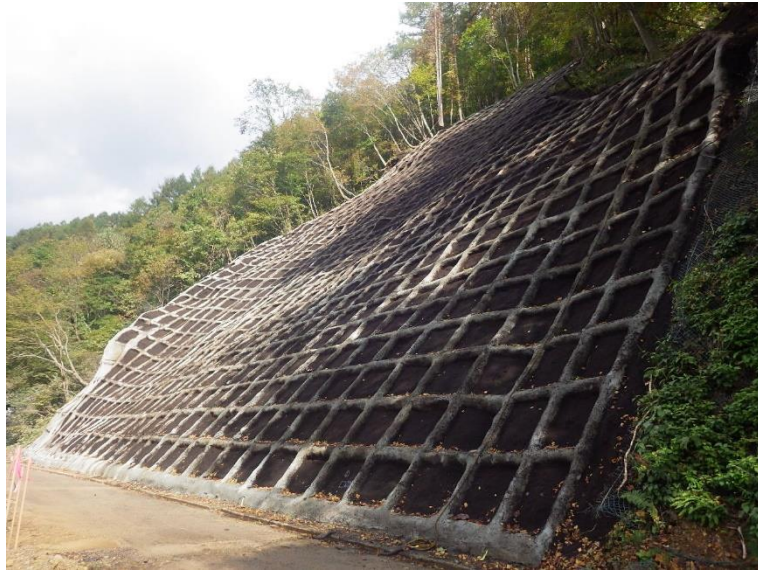
北本内川林道改良工事 岩手県北上市
