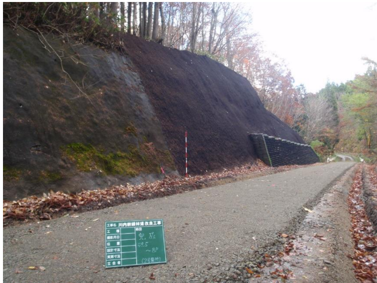
川内幹線林道改良工事 青森県むつ市
