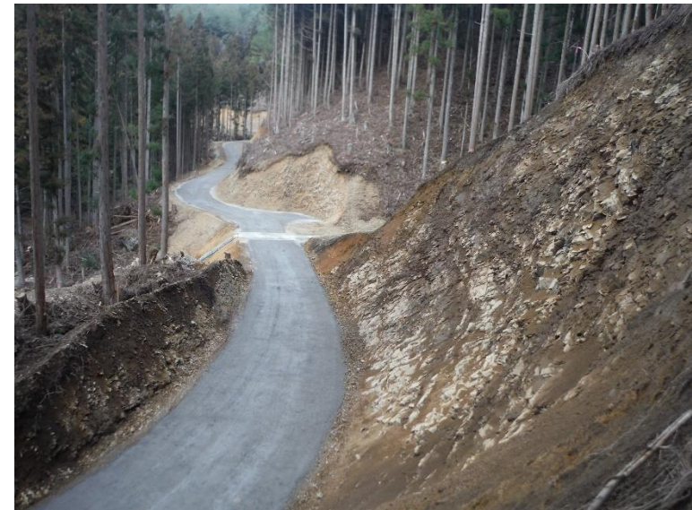
水月第2林道（林業専用道）新設工事 宮城県本吉郡南三陸町
