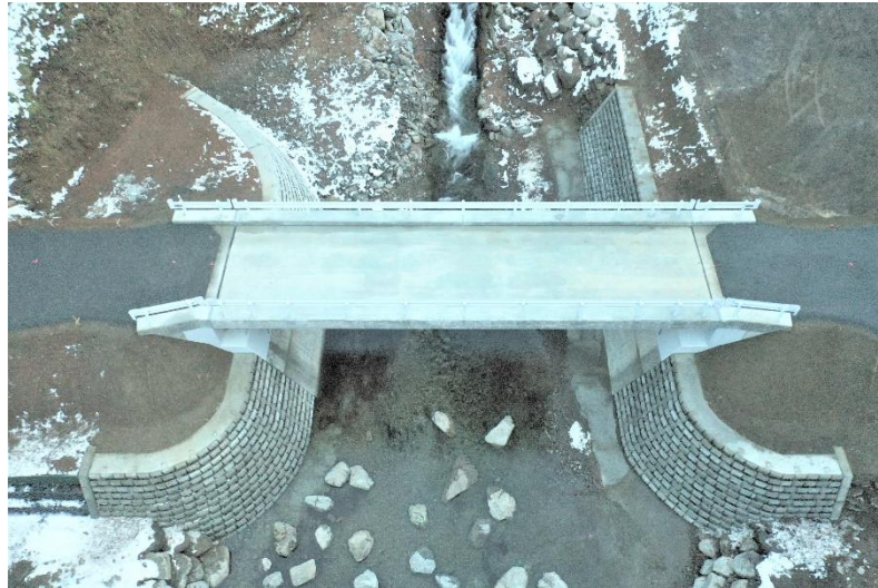
黒岩沢林道（林道専用道）新設工事 岩手県下閉伊郡岩泉町
