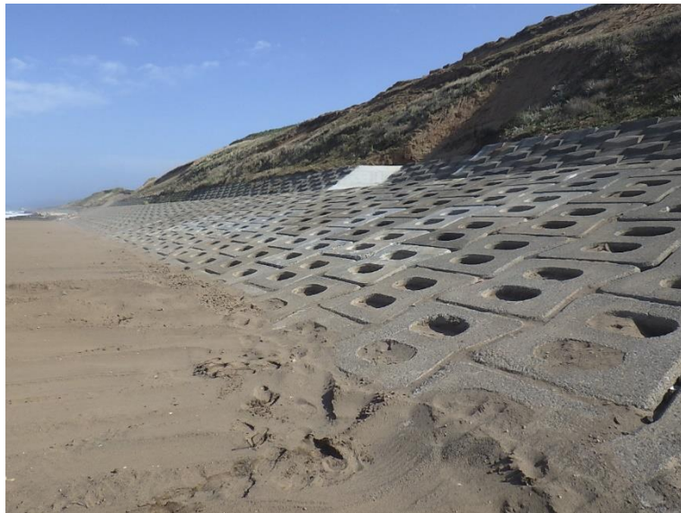
屏風山治山工事 青森県つがる市
