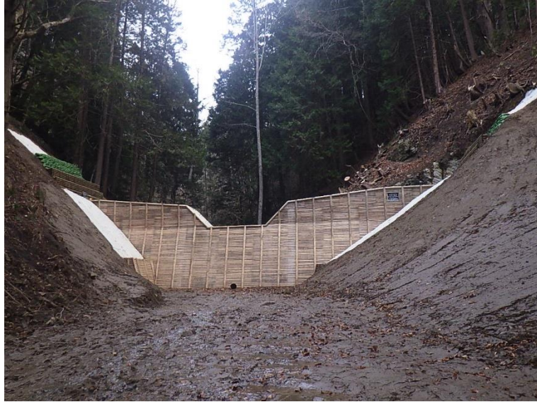
オチコ沢治山工事 青森県下北郡佐井村
