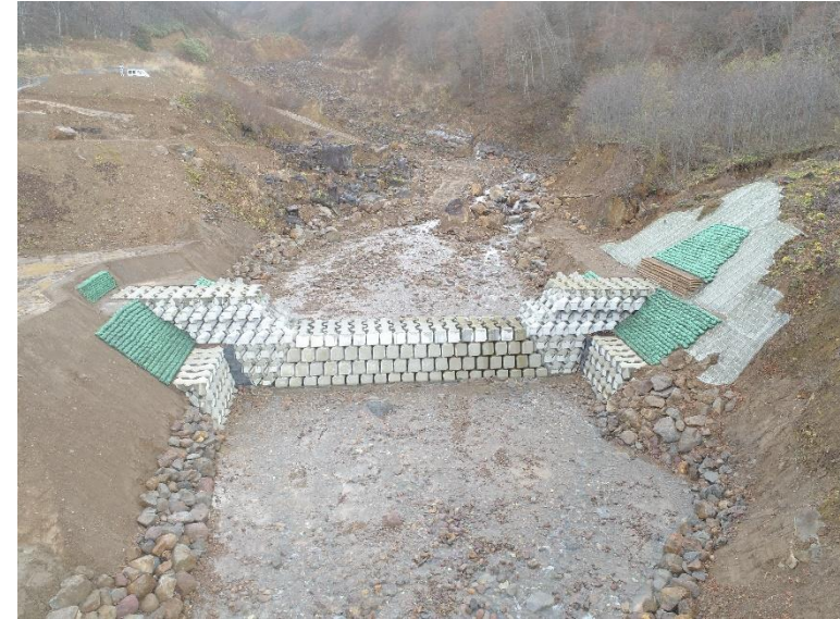
産女川第三治山工事 岩手県一関市
