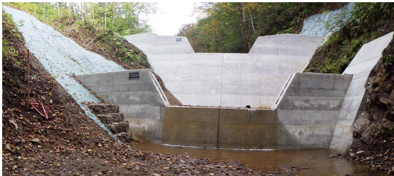
鳥崎中流部治山工事
