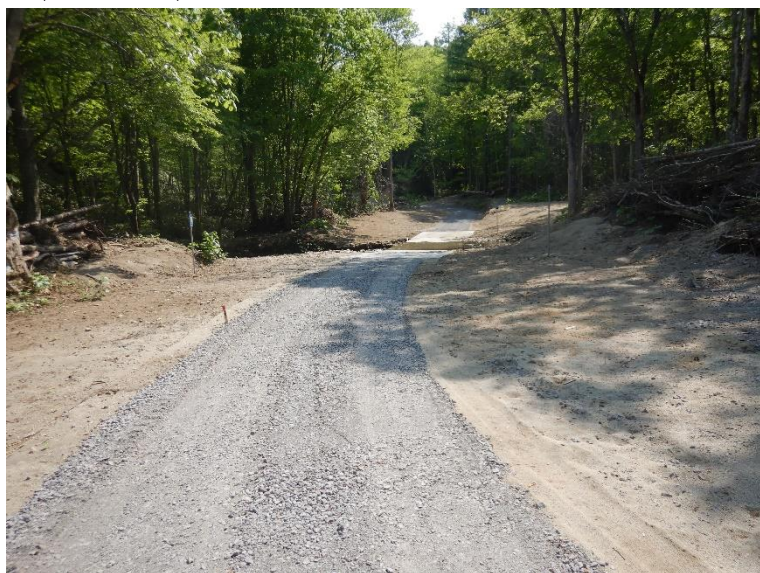
精進川線作業道（林業専用道（規格相当））新設工事 北海道森町 (株)石井組
