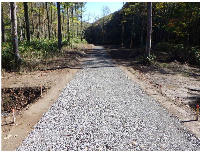
稀府林道（林業専用道）新設工事
