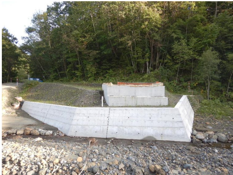
仁世宇林道改良工事
