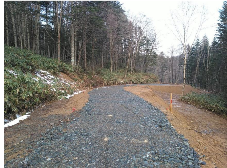
扇風機の沢作業道（林業専用道（規格相当））新設工事 北海道岩見沢市 及川産業(株)
