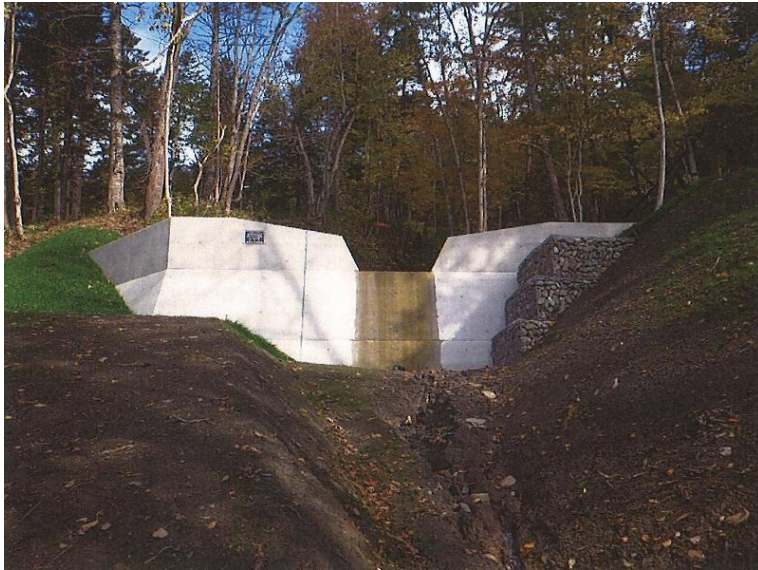
西桂沢治山工事
