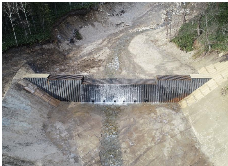
ペケレベツ川支流治山工事 北海道清水町
