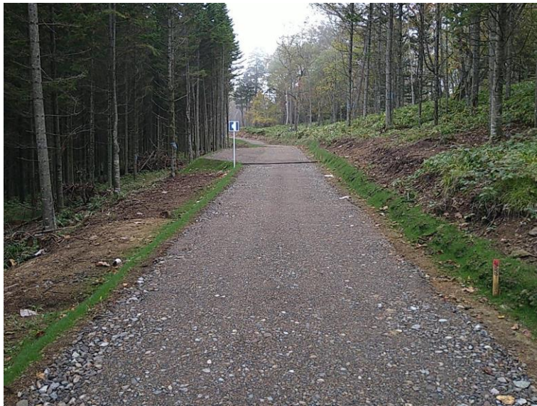
湯擬谷第1分線林道（林業専用道）新設工事
