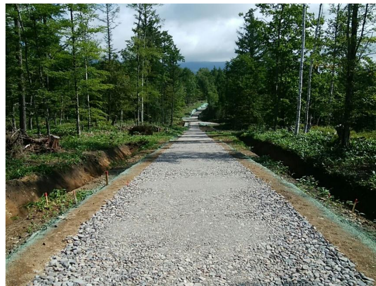
318 林班林道（林業専用道）新設工事 北海道足寄町
