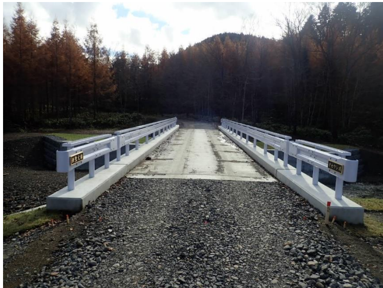
オセウシ林道改良工事 北海道滝上町
