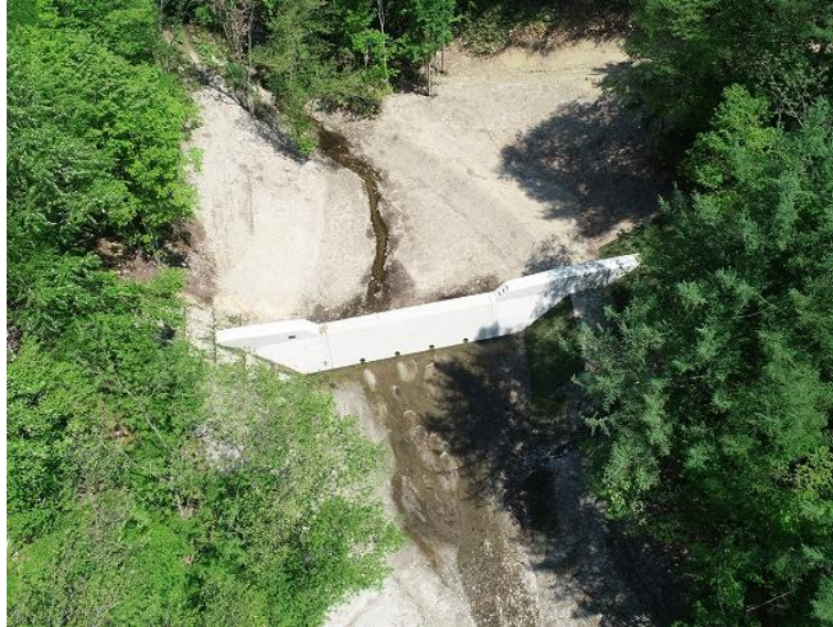
10号の沢治山工事 北海道遠軽町 〈林道工事〉
