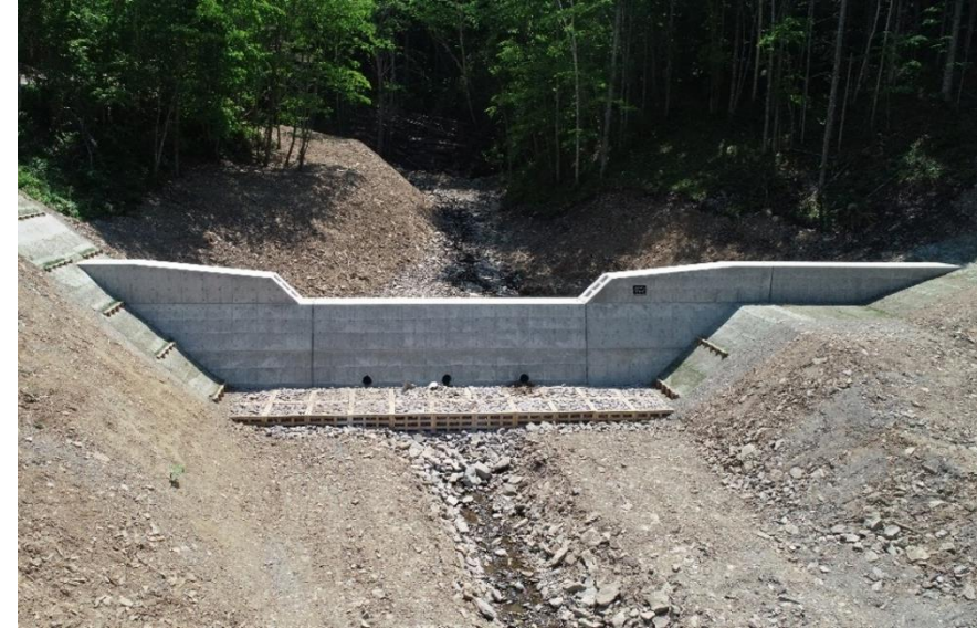
野上の沢治山工事 北海道遠軽町
