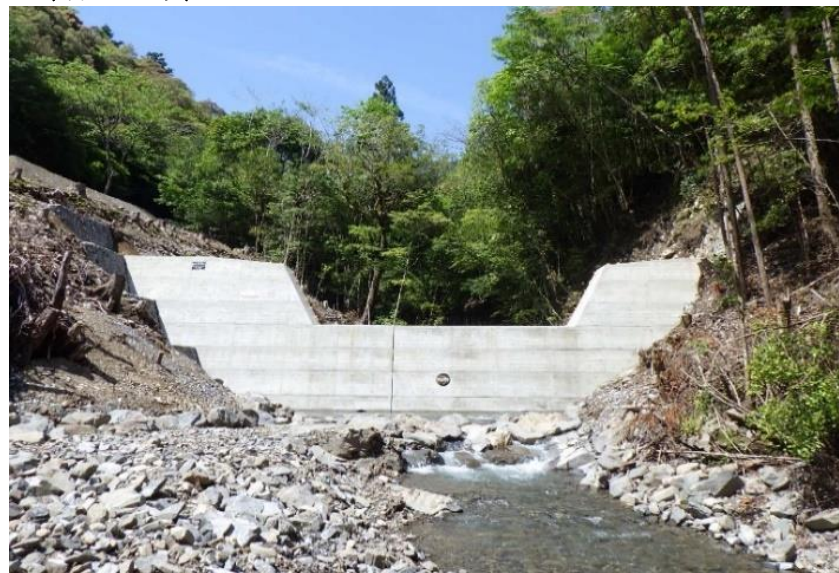
伊豆ヶ谷山（2053）復旧治山工事 高知県高岡郡四万十町 (有) 十和建設
