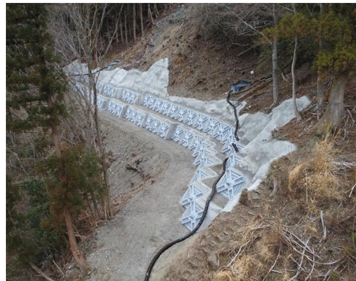
麦生土（23）復旧治山工事 高知県香美市 片田丸吉建設工業（株）
