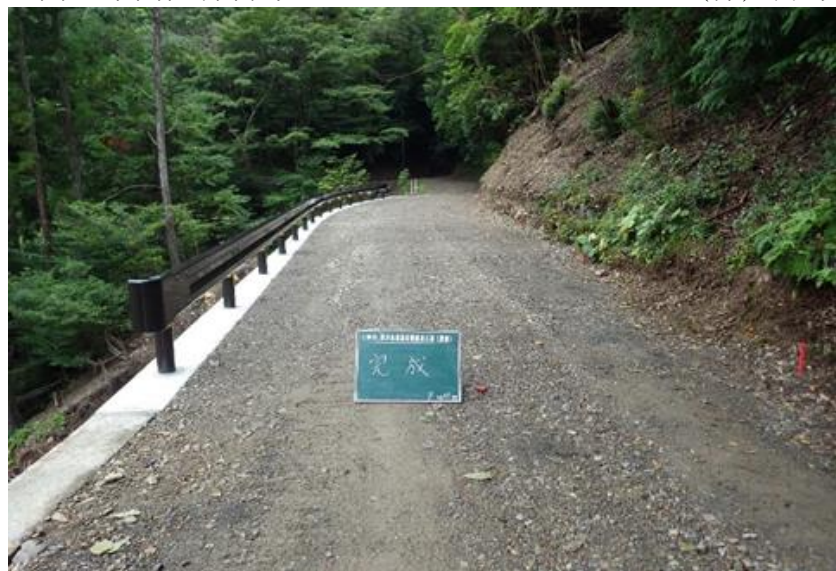
玖木山林道災害復旧工事 高知県四万十市
