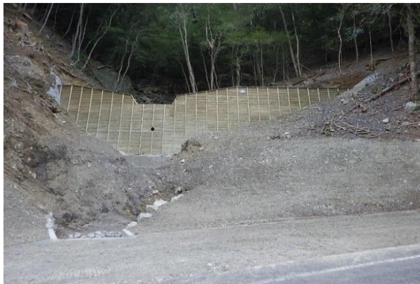
大森山（1202）復旧治山工事 高知県四万十市 (株) 大塚建設工業所
