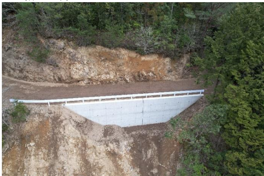
一の谷林道改良工事 高知県高岡郡梶原町
