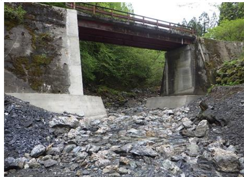
祖谷山林道笹谷線改良工事 徳島県三好市
