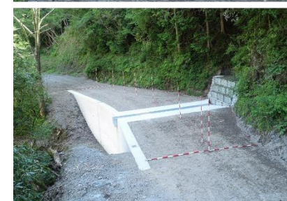
亀谷林道災害復旧工事 高知県安芸郡馬路村
