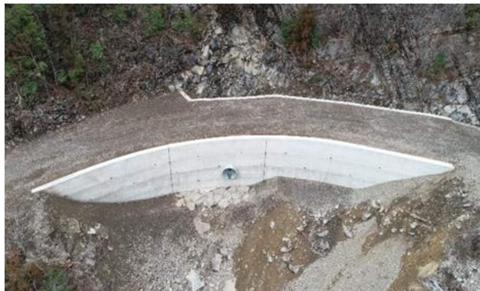
雁巻林道災害復旧工事 高知県安芸郡馬路村
