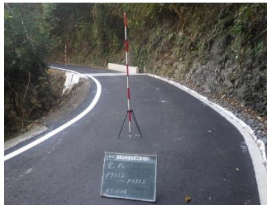
掃地山林道改良工事（明許） 高知県四万十市
