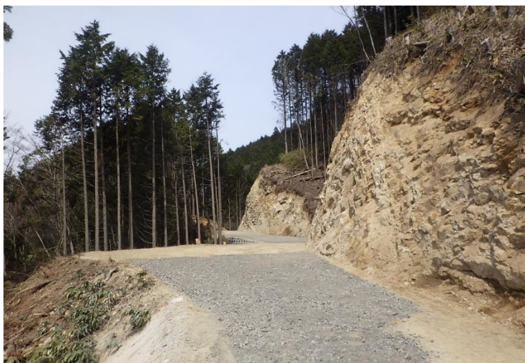
入江山林業専用道新設工事 島根県鹿足郡吉賀町
