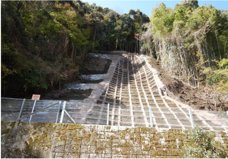
城山施設災害復旧工事
