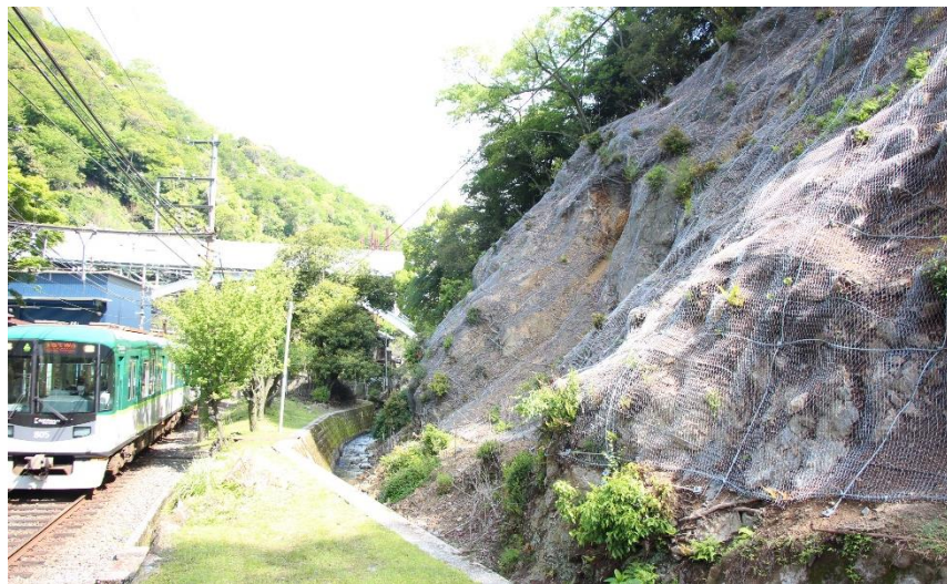
関寺外山腹工事 滋賀県大津市 〈林道工事〉
