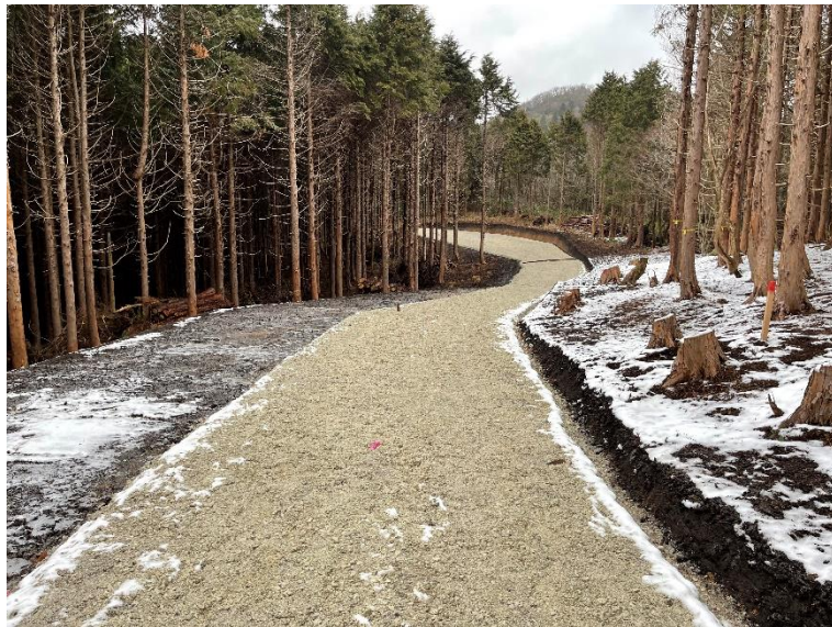
用郷山林道専用道新設工事
