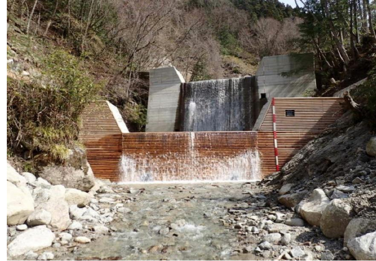
鎗ヶ入谷（本流）復旧治山工事-1 岐阜県恵那市
