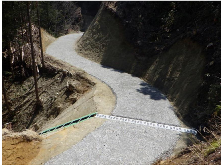
小ヌクイ大櫛林業専用道新設工事 岐阜県高山市
