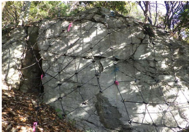
豊橋（二川）予防治山工事-1 愛知県豊橋市
