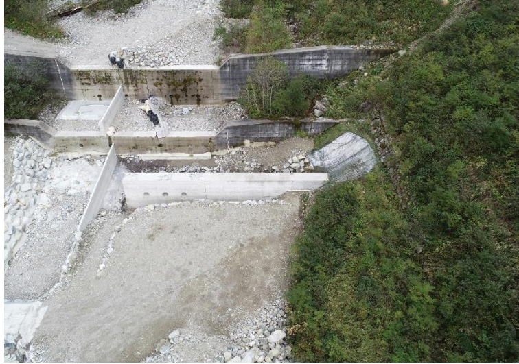
スゴ谷下流復旧治山工事 富山県富山市
