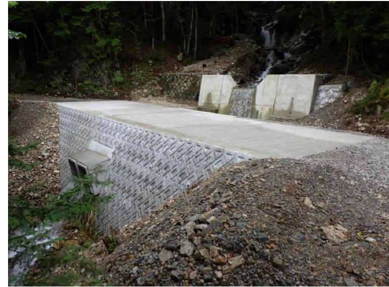
白川付知林道ほか1改良工事-2 岐阜県中津川市
