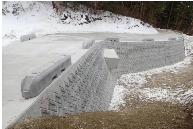
白ヶ久保林道災害復旧工事 岐阜県中津川市
