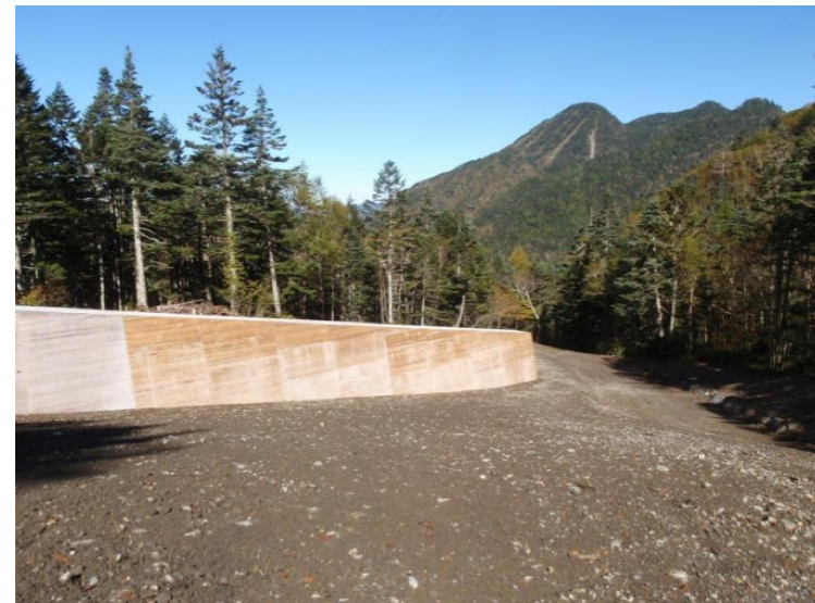
平湯（安房谷）水源地域整備工事 岐阜県高山市
