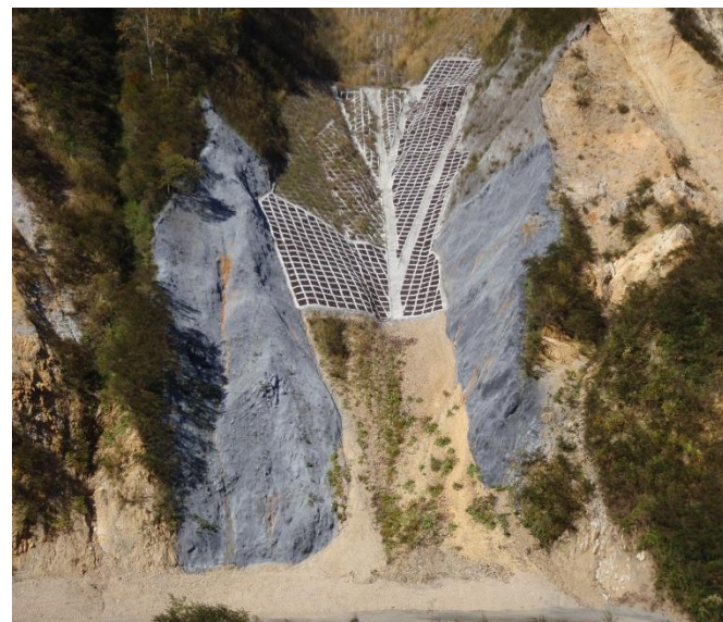
唐松沢2 復旧治山工事 長野県北安曇郡小谷村
