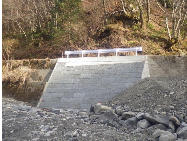
藪原林道災害復旧工事
