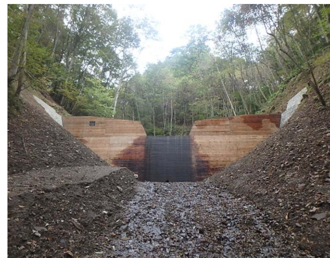
手良沢山2 復旧治山工事 長野県伊那市
