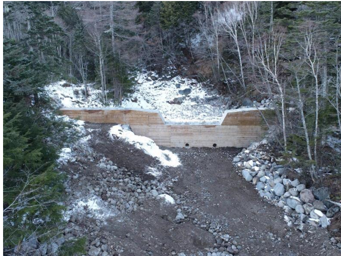
倉本湯川復旧治山工事 長野県木曾郡木曾町 〈林道工事〉
