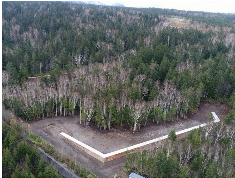
十勝岳治山工事その1 北海道美瑛町
