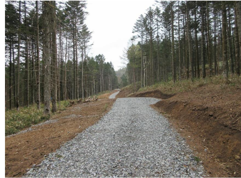
5線の沢林道（林業専用道）新設工事 北海道南富良野町
