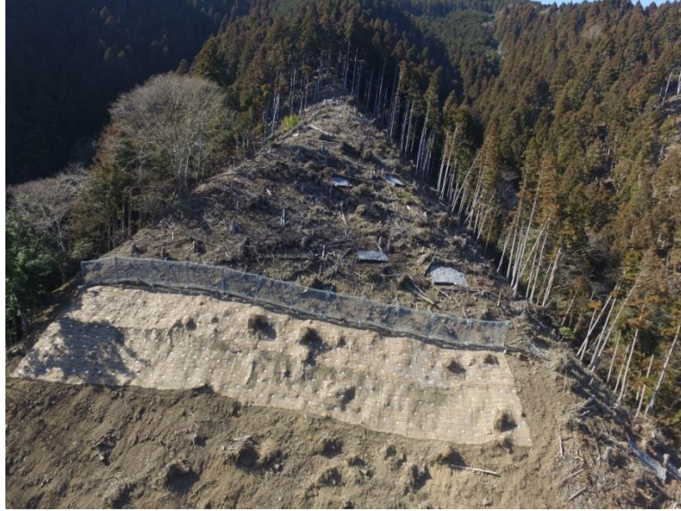
貴船山山腹工事
