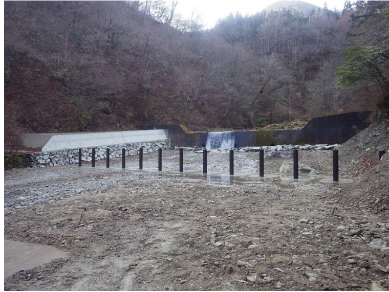
大河原（角巻谷）流木防止総合対策治山工事 岐阜県本巣市 黒田建設(株)
