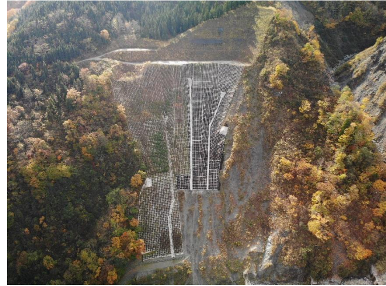
蒲原沢復旧治山工事 新潟県糸魚川市
