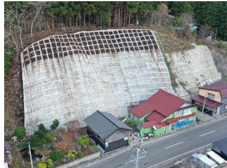
釜ノ沢治山工事 青森県外ヶ浜町
