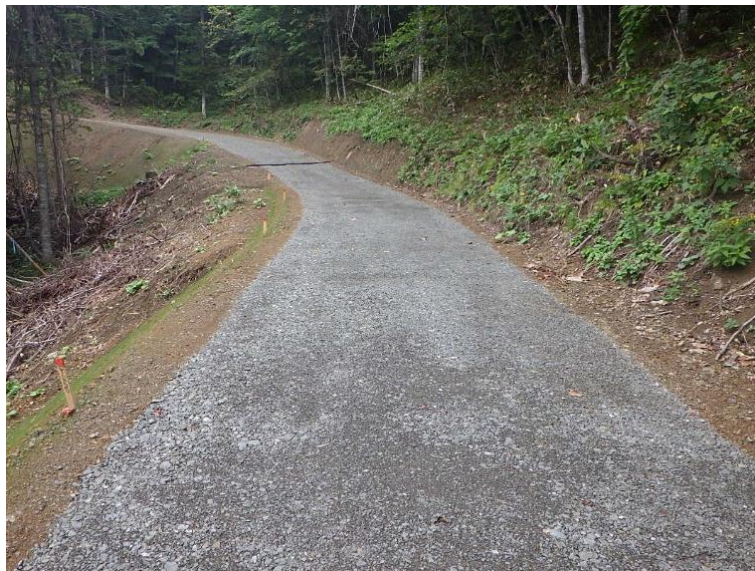
峠下左股（林業専用道）新設工事
