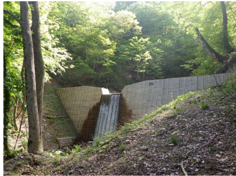
ワリ沢治山工事 秋田県湯沢市
