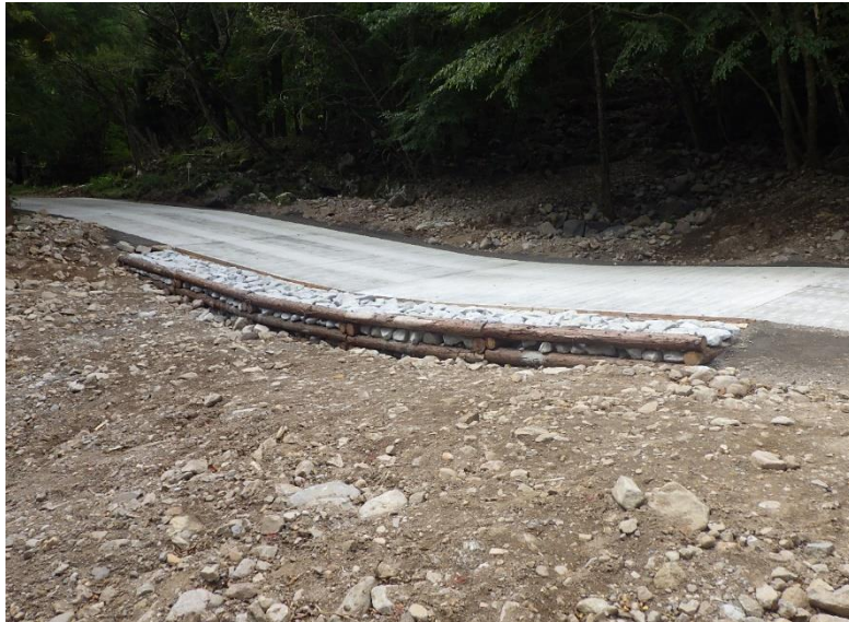
東部（奈良本）林道外1改良工事（R元補正） 静岡県東伊豆町 東海建設(株)
