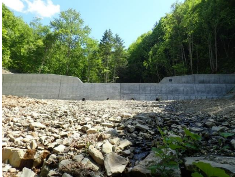
野上の沢治山工事
