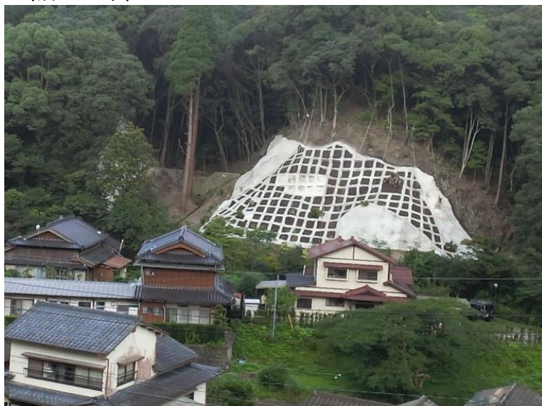
岩越治山工事 佐賀県有田町
