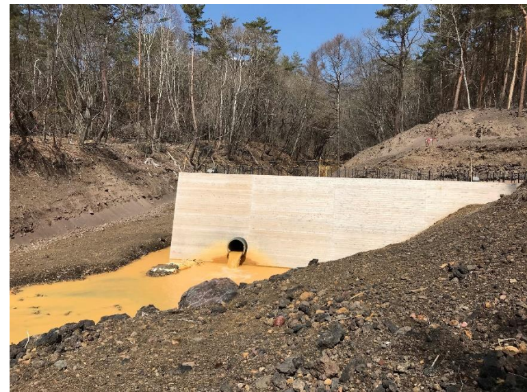
濁川地域防災対策総合治山工事 長野県軽井沢町
