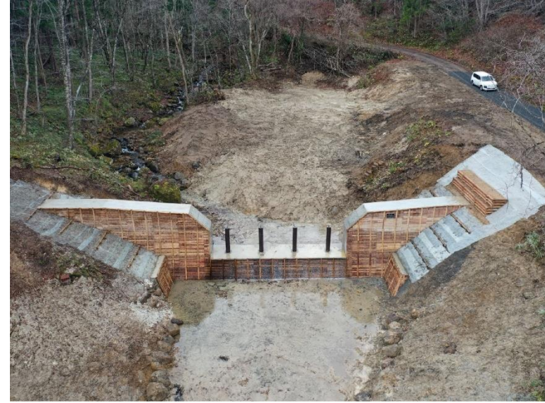
ヨリ沢治山工事 岩手県北上市
