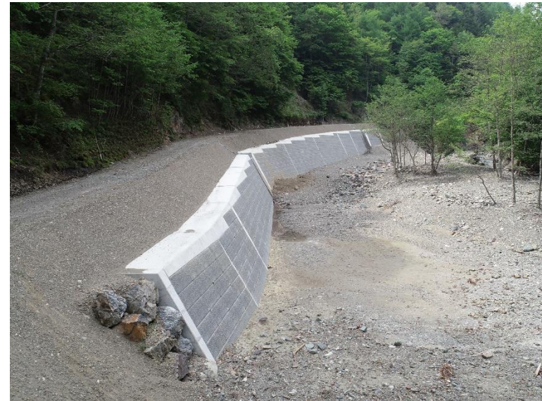
黒河内林道災害復旧工事2 長野県伊那市 小澤建設(株)
