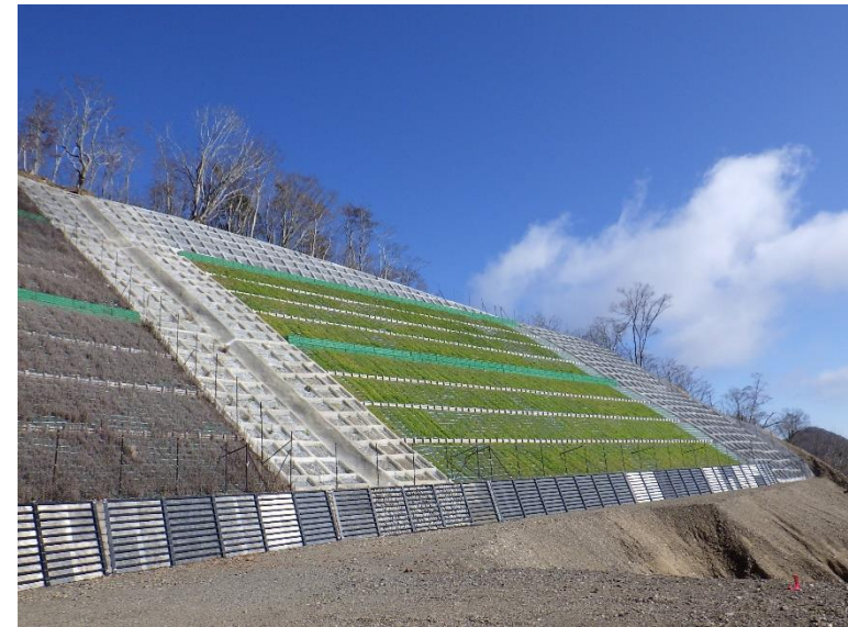
榛原川ホーキ薙復旧治山工事（R元ゼロ国） 静岡県川根本町
