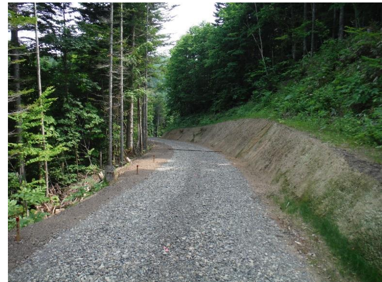
上古丹3号沢支線林道（林業専用道）新設工事
