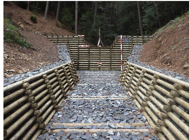
豊橋（梅田川支流）復旧治山工事 愛知県豊橋市 今泉建設(株)
