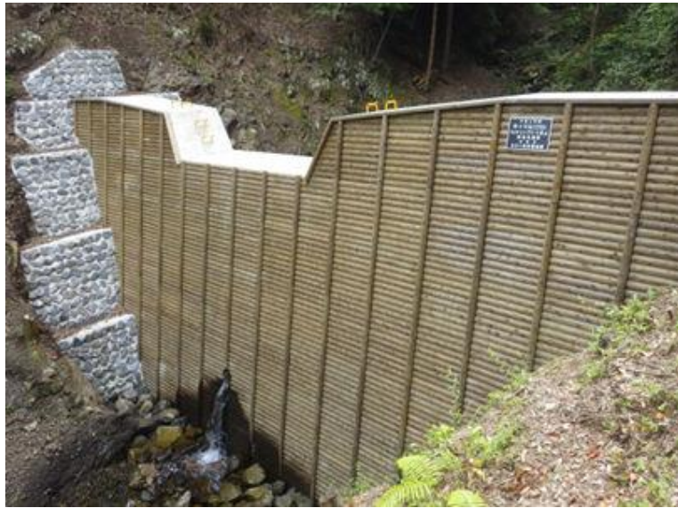
野々川山(2032)復旧治山工事(明許) 高知県四万十町 (有) 松元建設
