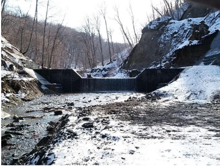
立惣辺沢治山工事 青森県十和田市
