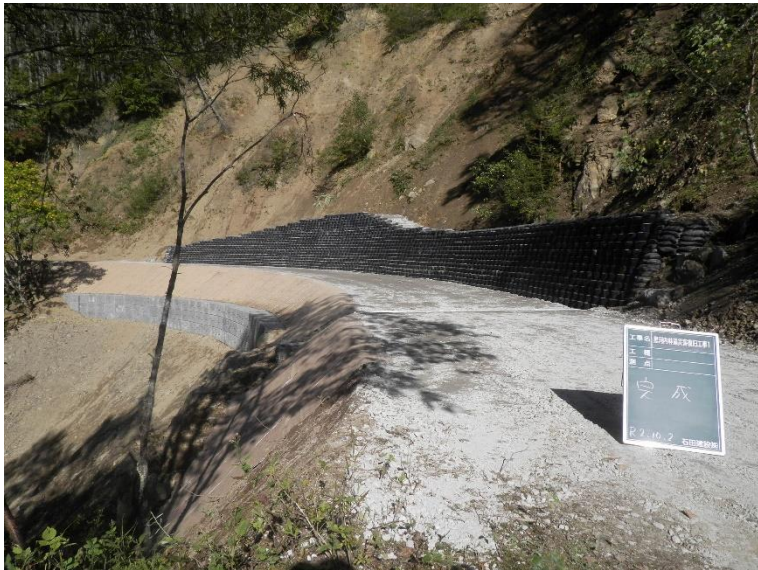
黒河内林道災害復旧工事1 長野県伊那市 石田建設(株)
