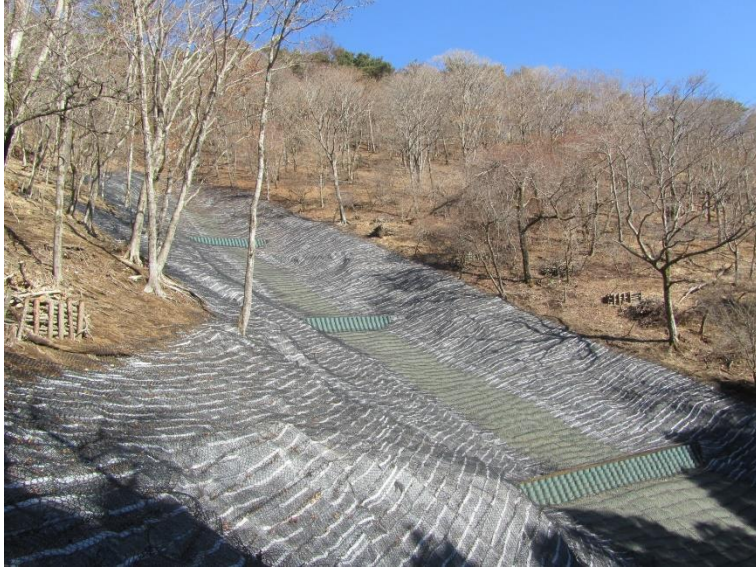
須走地区（立山 2.3.4）復旧治山工事 静岡県小山町
