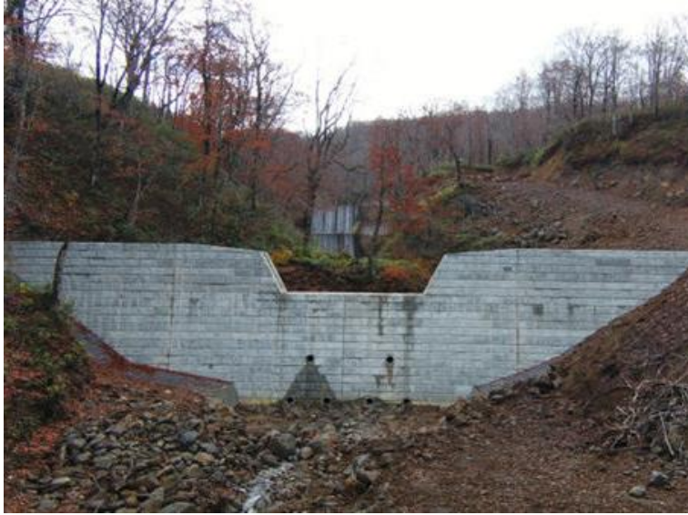
黒湯沢第二治山工事 秋田県仙北市
