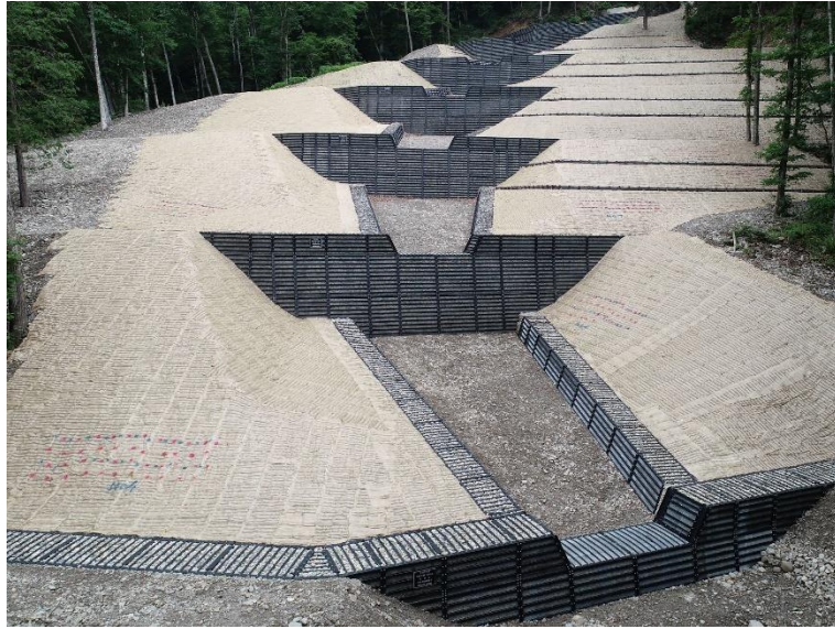
中白沢復旧治山工事 長野県大町市
