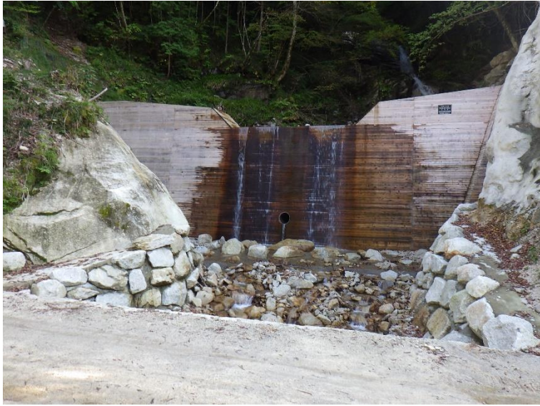
伊奈川（ヤケ小屋）復旧治山工事 長野県南木曾町 〈林道工事〉 (株)名工土木
