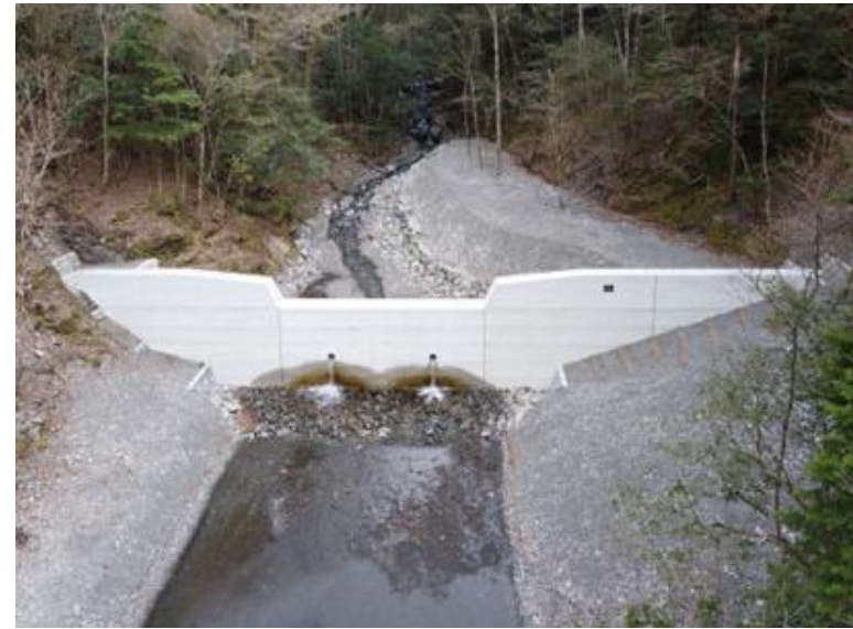
宇筒舞山(88)復旧治山工事(明許) 高知県香美市 高大建設(株)
