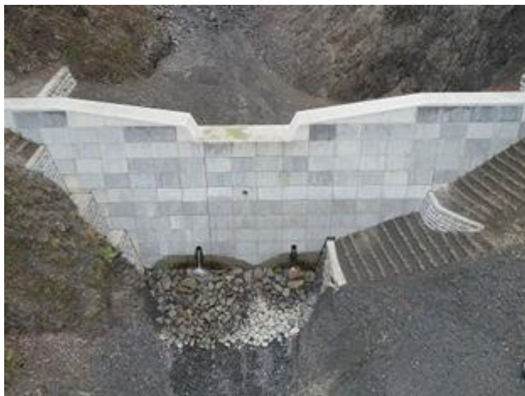
南亀谷山(2015)復旧治山工事（翌債） 高知県馬路村 魚梁瀬産業（有）
