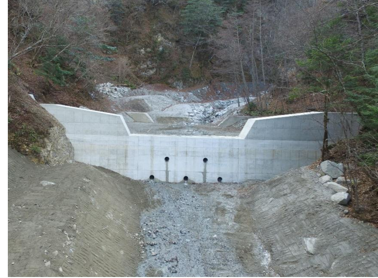
小武川湯沢復旧治山工事（R元補正） 山梨県韮崎市
