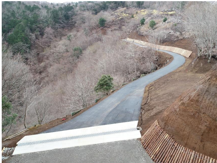
法行沢林業専用道新設工事 神奈川県山北町 河津建設(株)
