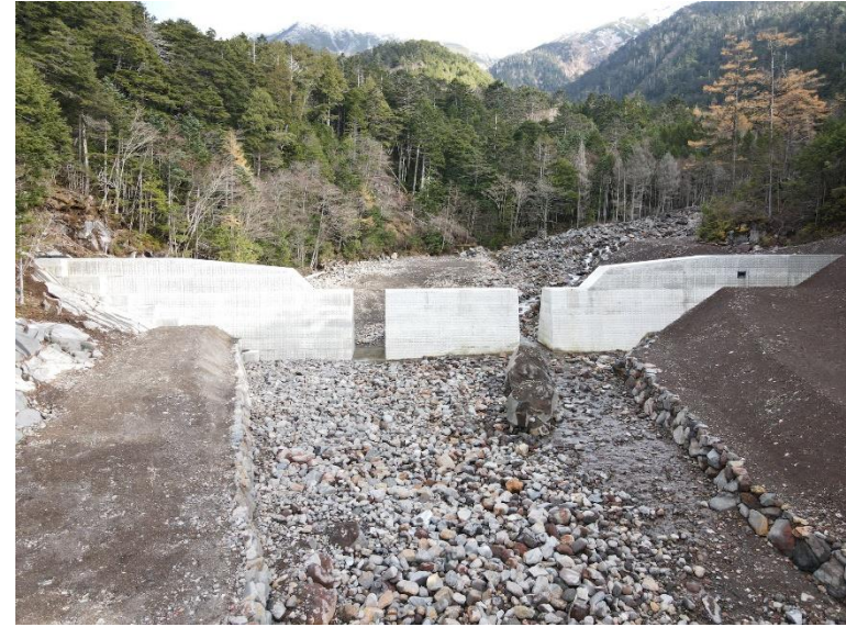
濁河（草木谷）復旧治山工事 岐阜県下呂市 (株)梅田組
