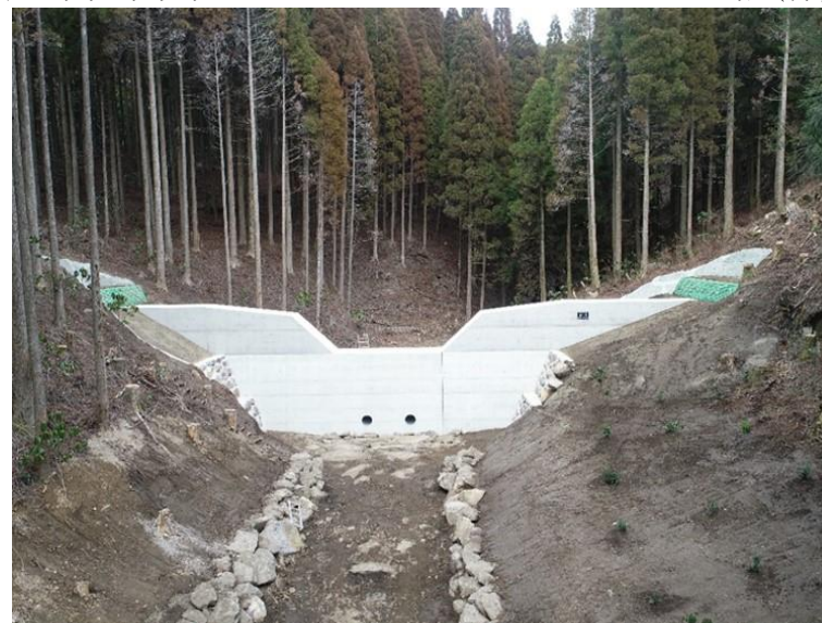
霧島山治山工事 鹿児島県霧島市
