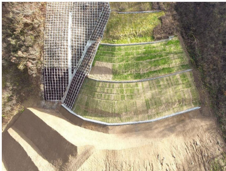
土谷川地すべり工事 長野県小谷村
