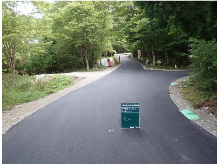
霧ヶ原林業専用道新設工事 岐阜県中津川市
