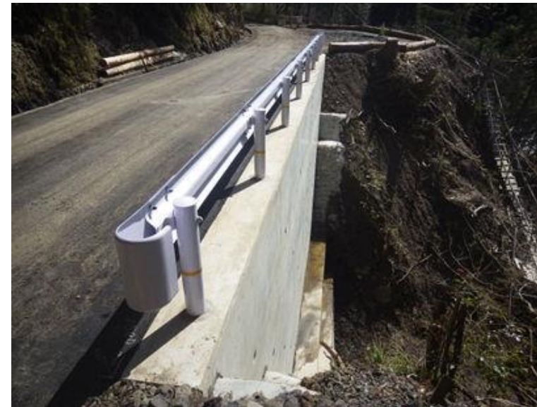
竹屋敷林道災害復旧外1工事（明許） 高知県北川村
