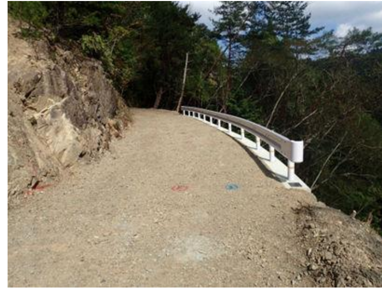
一の谷林道改良工事（翌償） 高知県檮原町
