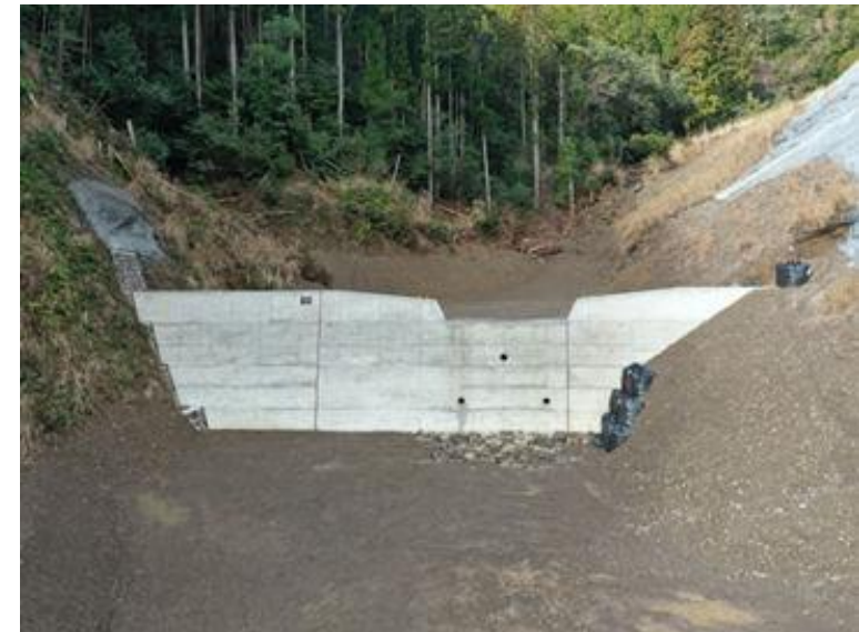
後口山(1003)復旧治山工事(国債) 高知県北川村 (有) 金本組
