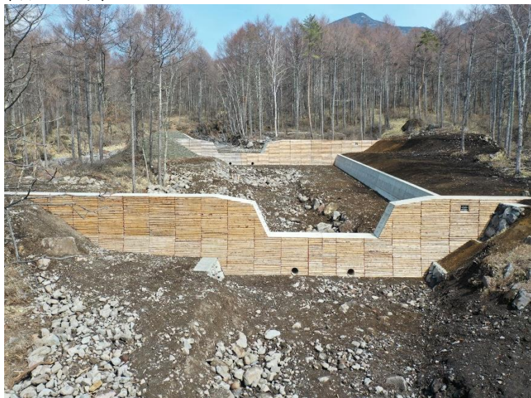
キッカケ沢復旧治山工事
