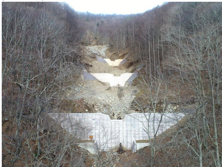
笛吹地区治山工事
