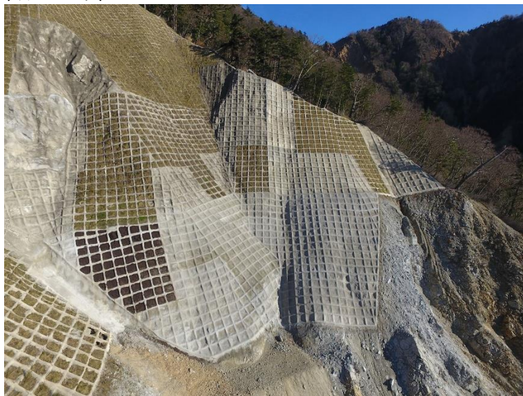
姥ナギ沢復旧治山工事
