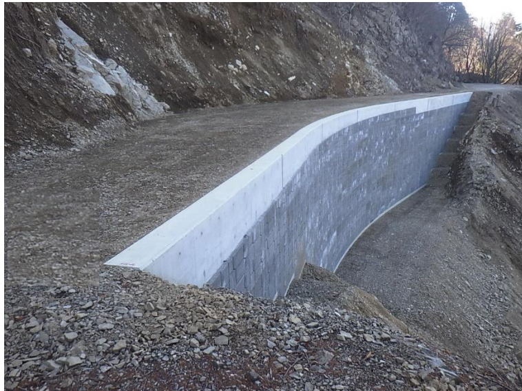
南赤石（寸又左岸）林道改良工事 静岡県川根本町 (株)柳澤組
