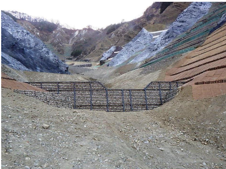
鳶ヶ巣2復旧治山工事
