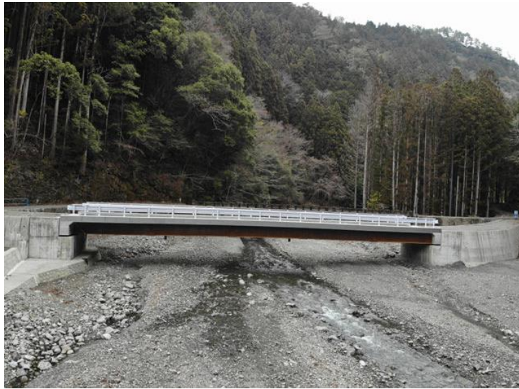
桑の川林道橋梁上部工架設工事（翌債）
