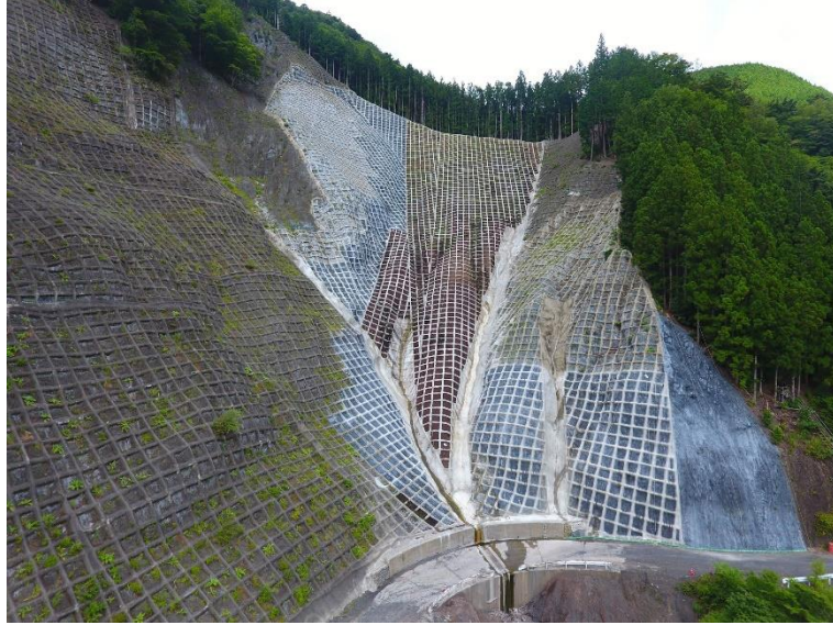
榛原川100崩復旧治山工事 静岡県川根本町 〈林道工事〉 (株)梶山組
