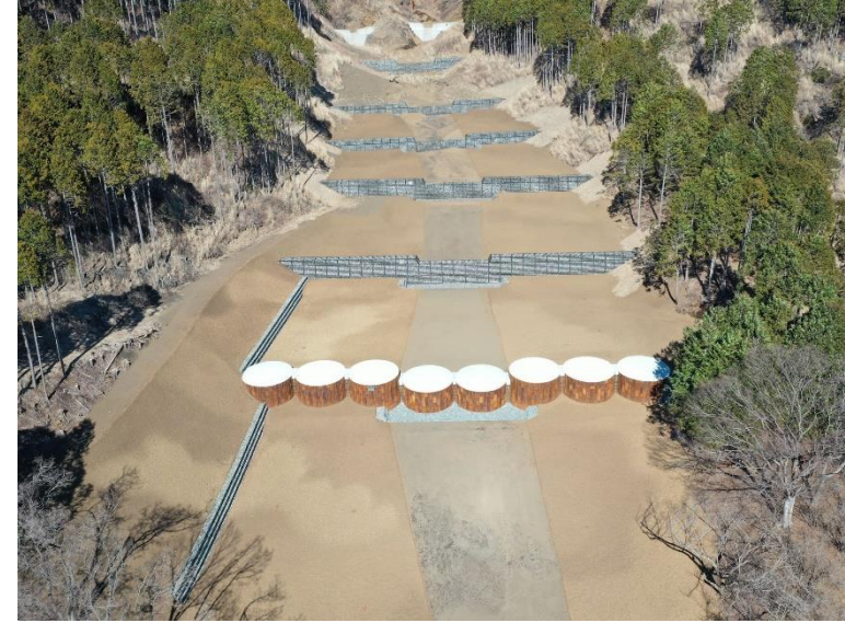
北郷地区（大御神2）復旧治山工事 静岡県小山町 (株)白鳥建設
