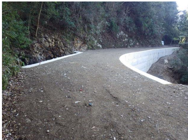
勝間林道55支線改良工事（明許）
