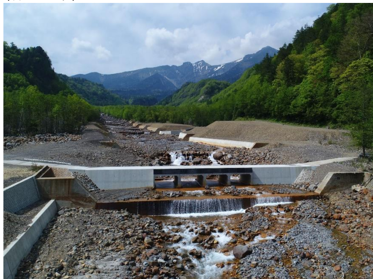
御岳御厩野林道改良工事
