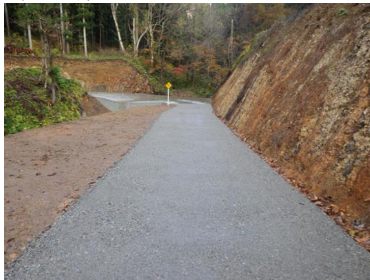
番鳥沢作業道（林業専用道）新設工事
