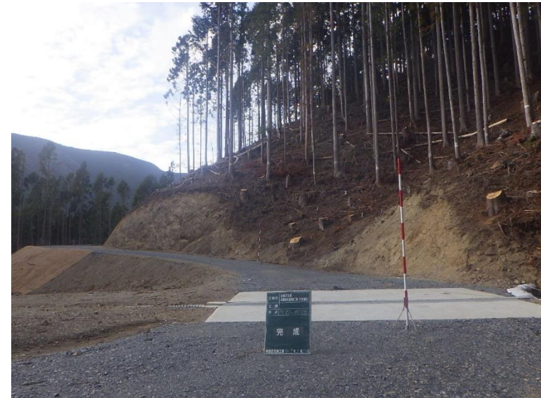
金剛沢支線林業専用道新設工事（R元補正） 静岡県浜松市 (株)渡辺兄弟工業
