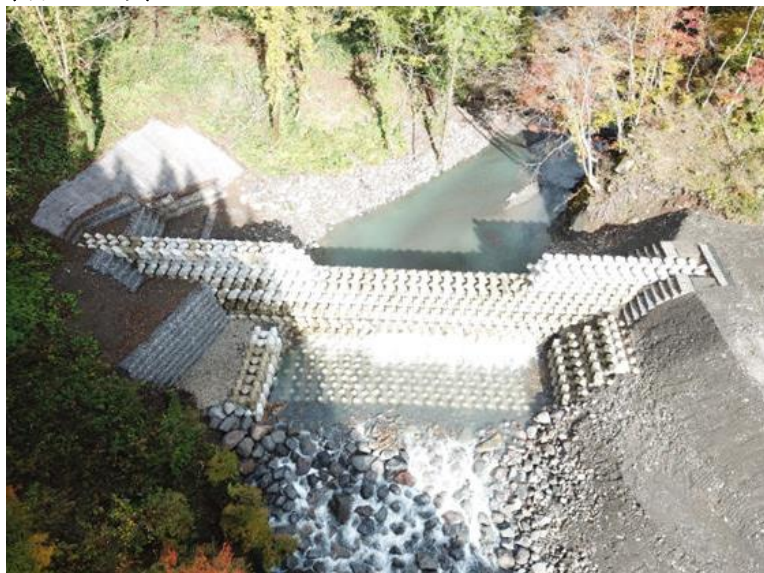
鹿ノ俣沢治山工事
