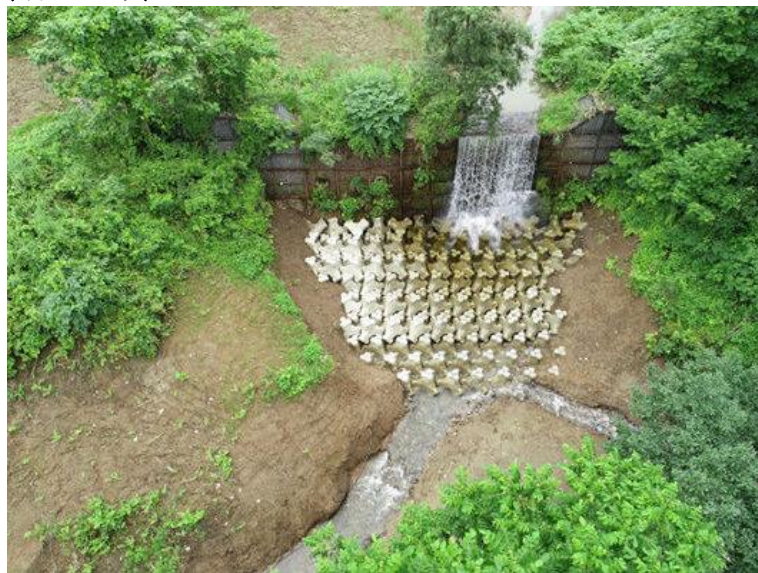
上山地域（桜峯外）地すべり防止工事（R元翌債）
