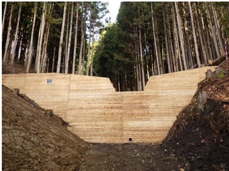
矢竹上流地区予防治山工事 群馬県東吾妻町 〈林道工事〉
