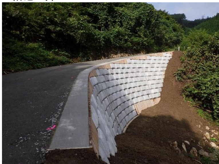
三島林道災害復旧工事 群馬県東吾妻町
