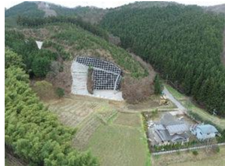
渡瀬地区復旧治山工事（R元補正） 福島県鮫川村
