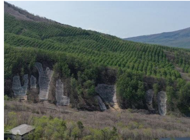
鹿沢地区災害関連緊急治山工事 群馬県嬲恋村
