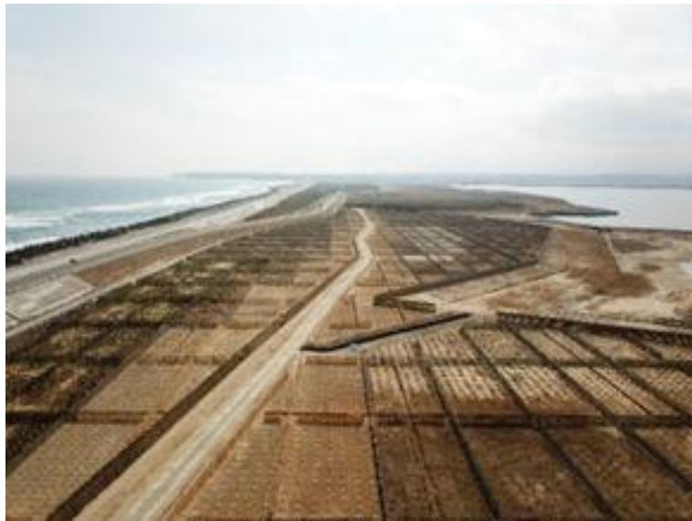
松川浦地区海岸防災林造成工事 福島県相馬市
