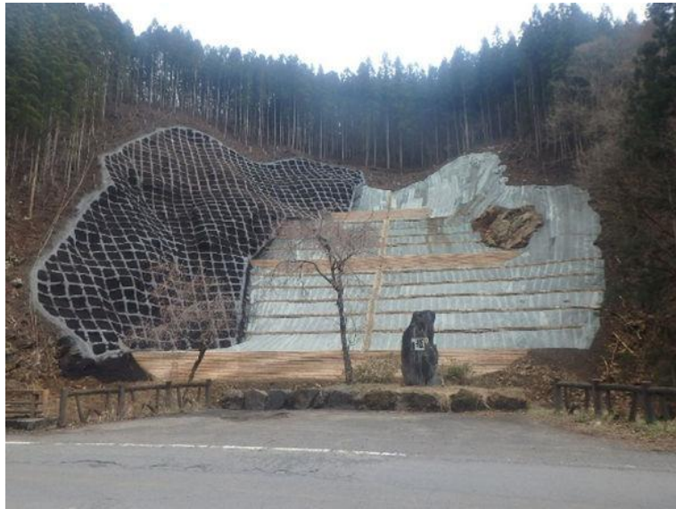
戸中地区（白子川）復旧治山工事 福島県棚倉町
