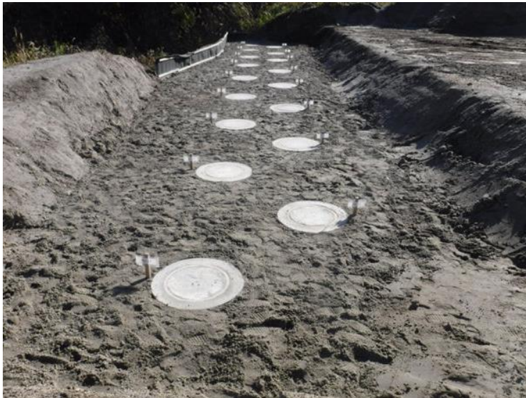
蟬の沢地区地すべり防止工事(鋼管杭) 山形県大蔵村
