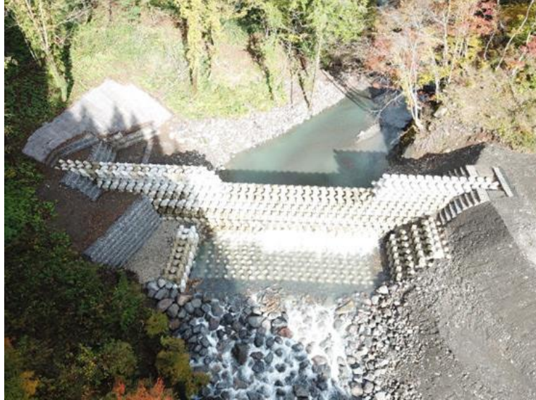
鹿ノ俣沢治山工事
