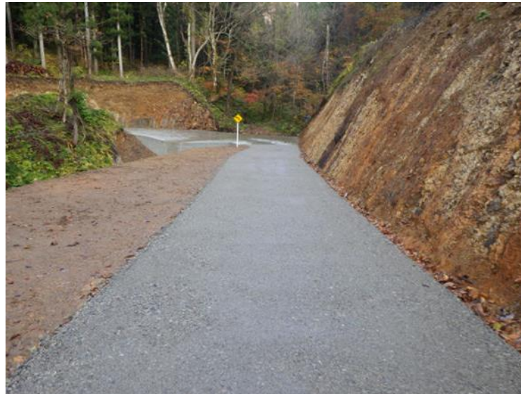
番鳥沢作業道（林業専用道）新設工事
