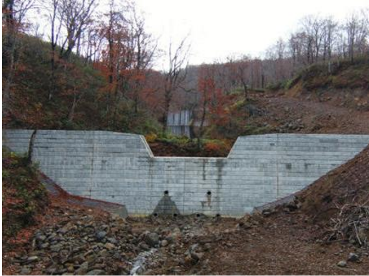
黒湯沢第二治山工事 秋田県仙北市
