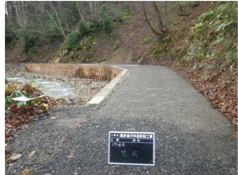
奥赤倉沢林道（林業専用道）新設工事 秋田県湯沢市
