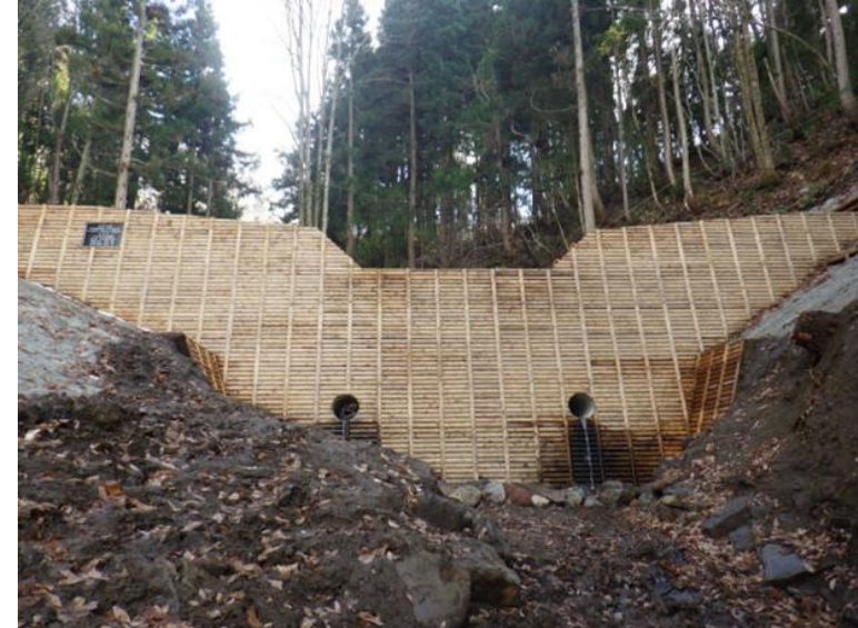
蔵王温泉地区災害関連緊急治山工事 山形県山形市
