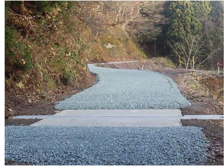
鉛山林道改良工事 山形県尾花沢市
