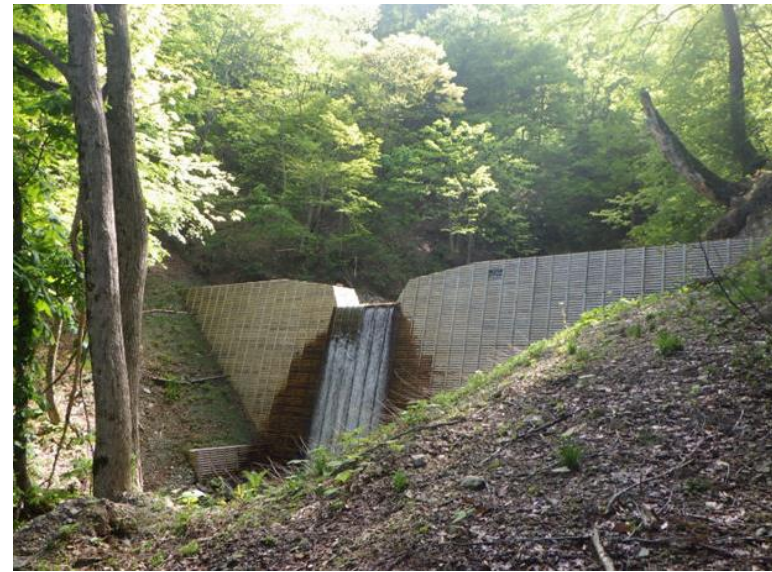
ワリ沢治山工事 秋田県湯沢市
