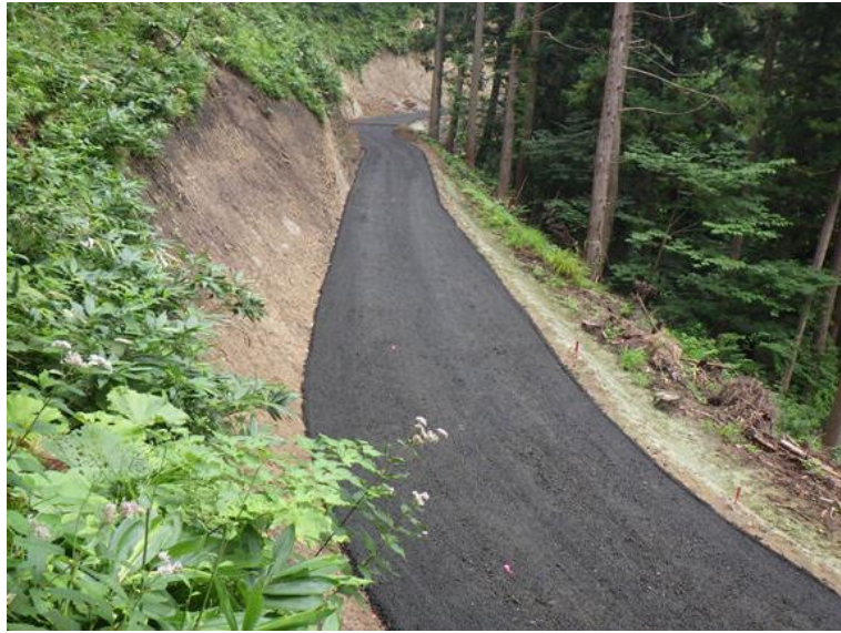
松沢林道（林業専用道）新設工事 秋田県北秋田市
