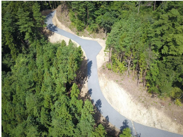
大沢山林道（林業専用道）新設工事
