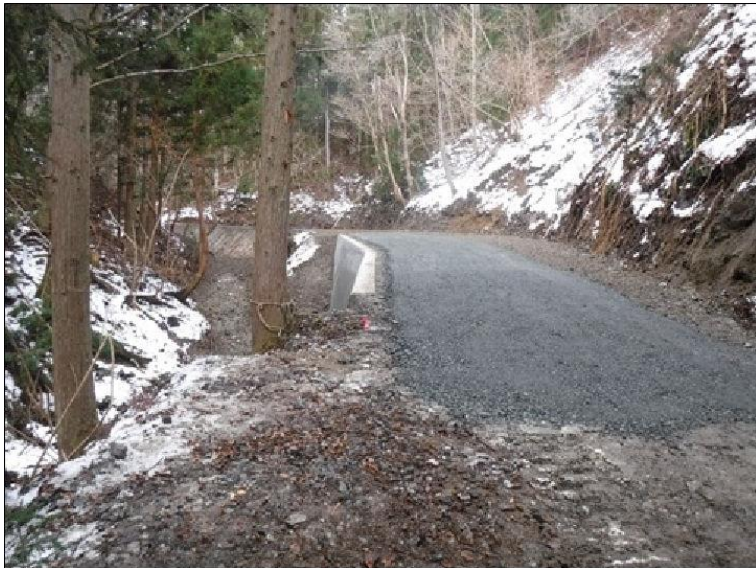
中の沢林道外災害復旧工事 宮城県登米市 (株)笹原組
