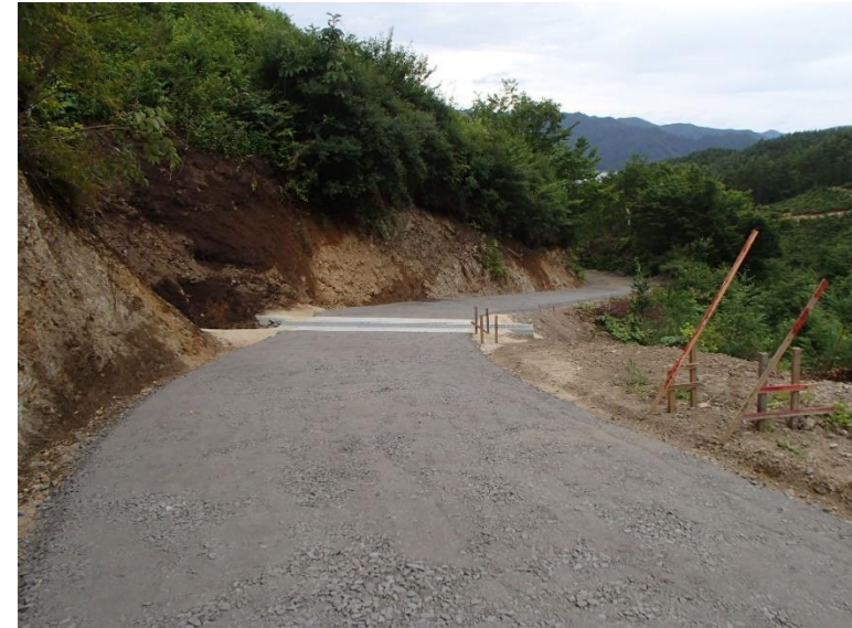
半崎林道災害復旧・改良工事 岩手県山田町 刈屋建設(株)
