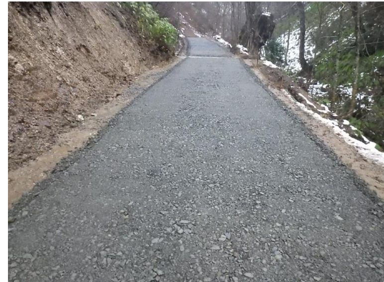
鬼泊林道改良工事 青森県今別町 相内建設(株)
