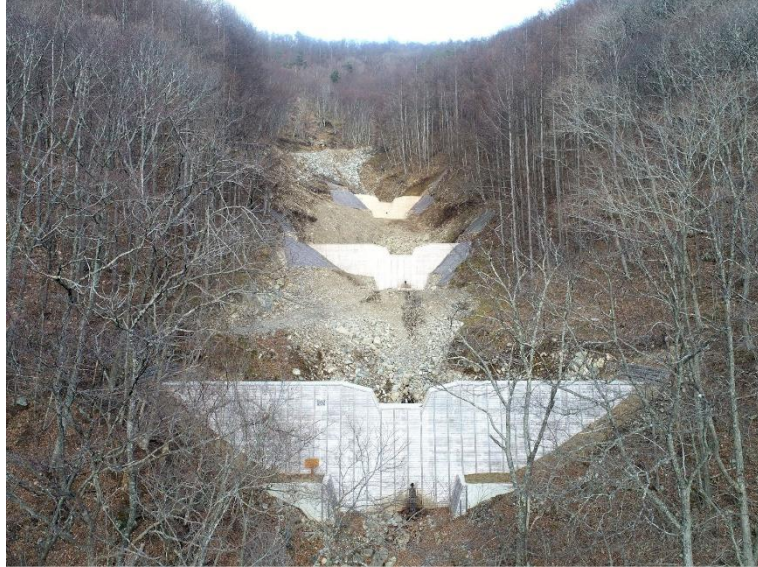
笛吹地区治山工事
