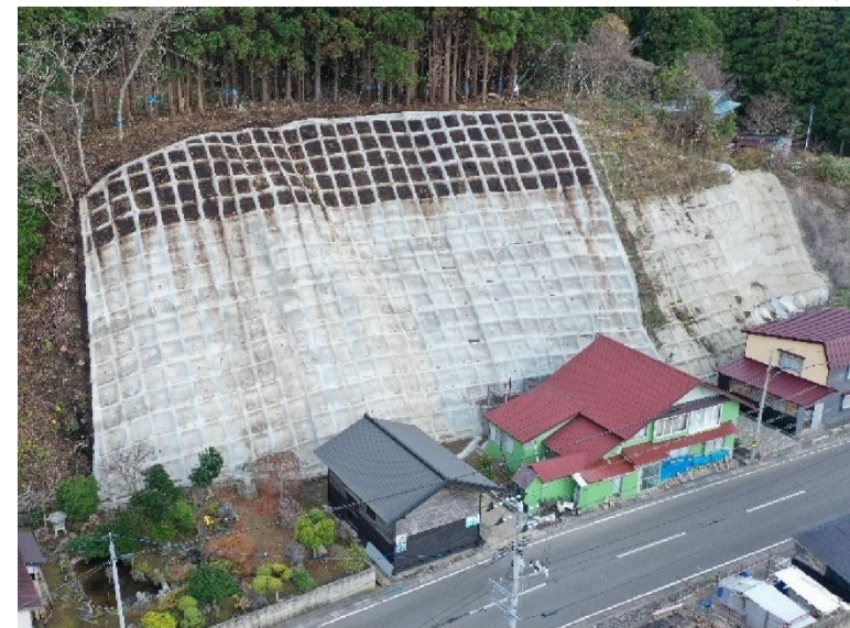
釜ノ沢治山工事 青森県外ヶ浜町
