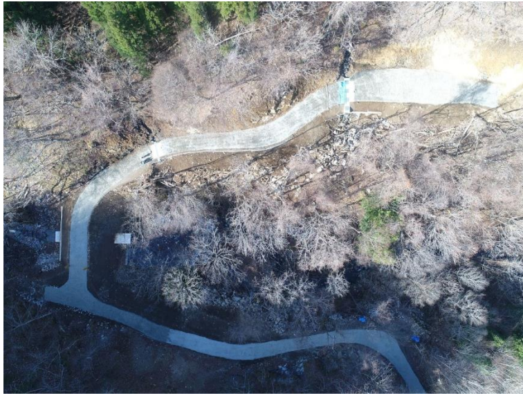
大森沢林道（林業専用道）外新設・改良工事 岩手県釜石市 工藤建設(株)
