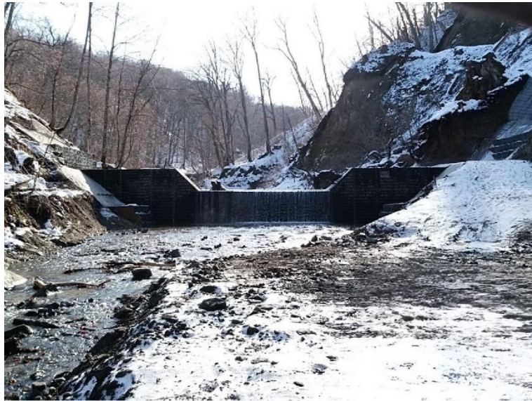
立惣辺沢治山工事 青森県十和田市
