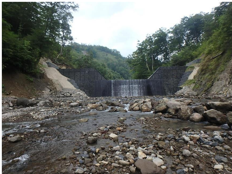
湯ノ倉上流第二治山工事 宮城県栗原市
