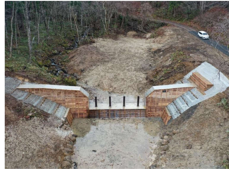
ヨリ沢治山工事 岩手県北上市
