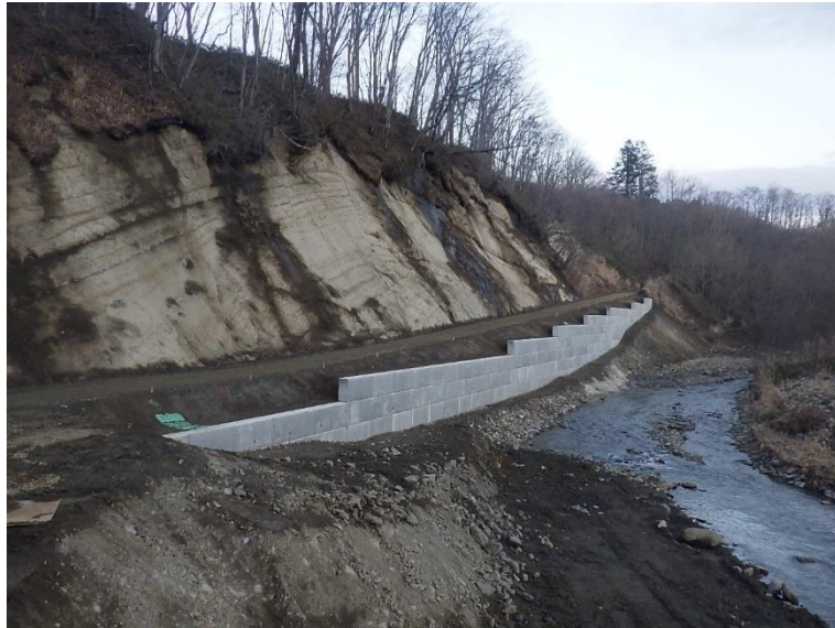
釜別林道改良工事 北海道八雲町
