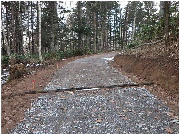
田中工場の沢林道小錫の沢支線二の沢分線（林業専用道）新設工事
