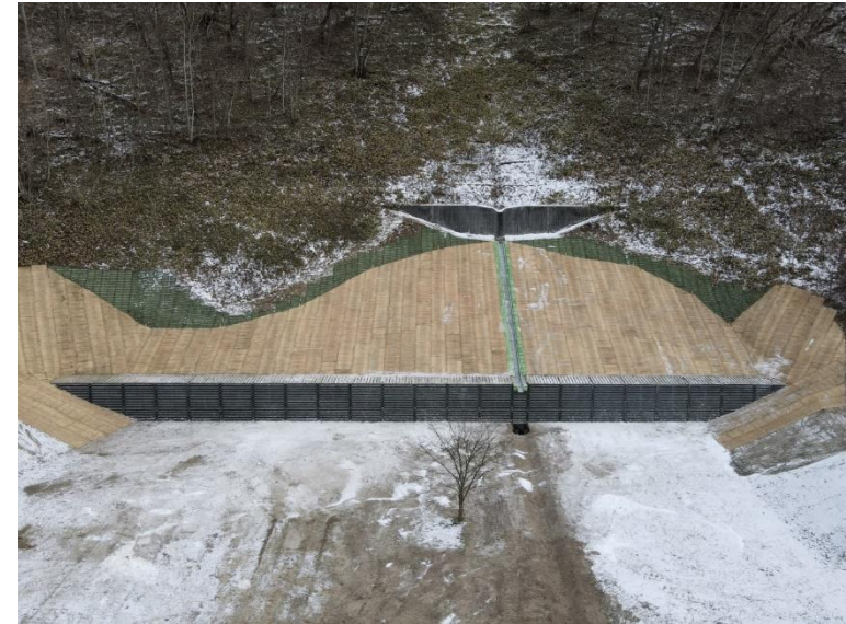
佐伯地先の沢治山工事 北海道新冠町
