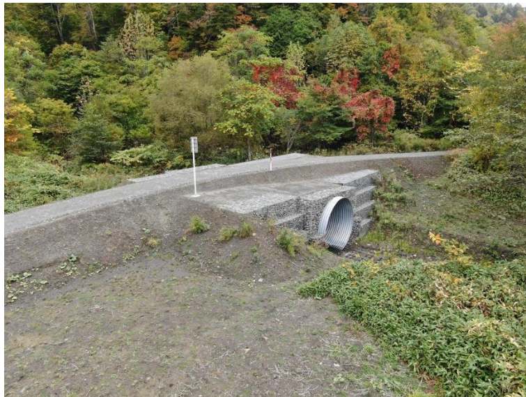
穂別林道新登川線改良工事 北海道むかわ町
