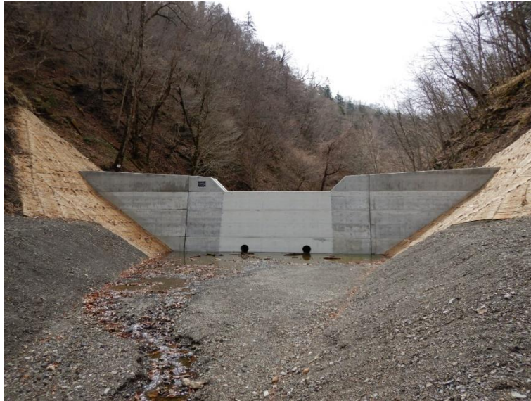
七沢越五の沢治山工事 北海道日高町 〈林道工事〉
