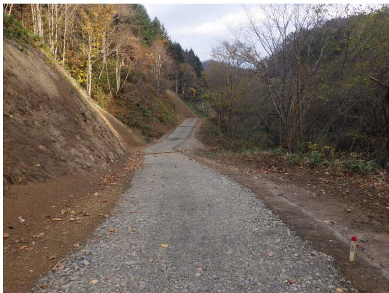
礼桂連絡林道（林業専用道）新設工事 北海道石狩市
