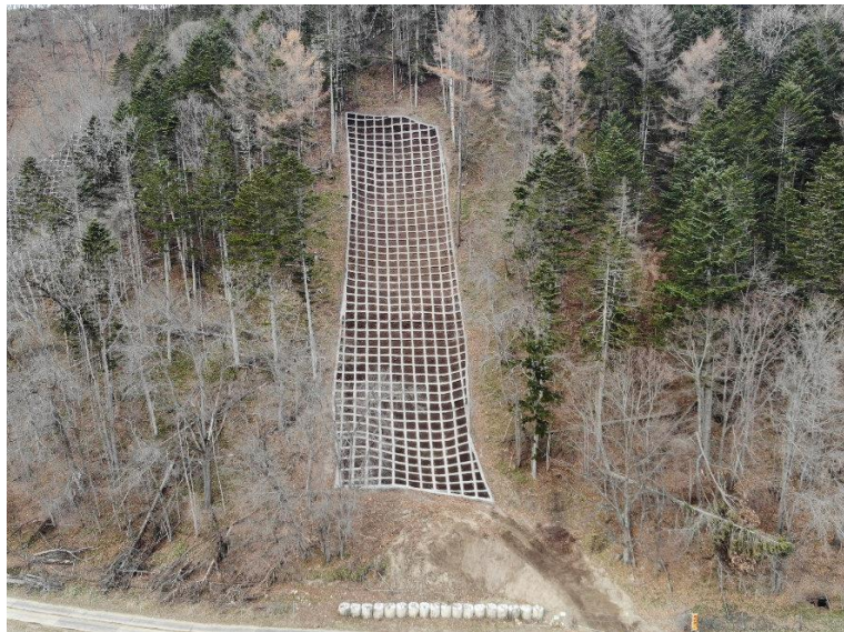
東本別治山工事
