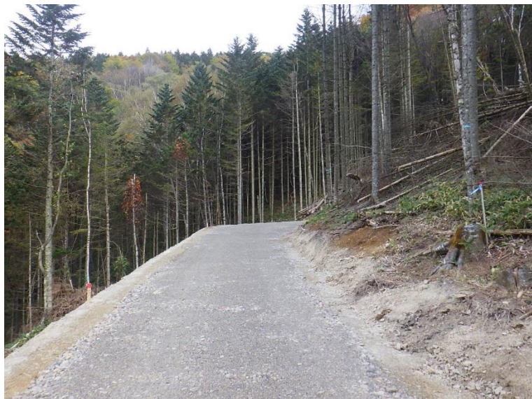
奥瓜幕2号林道（林業専用道）新設工事
