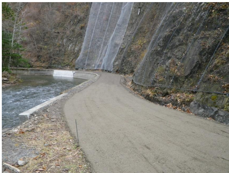
シュンクシタカラ林道改良工事 北海道釧路市
