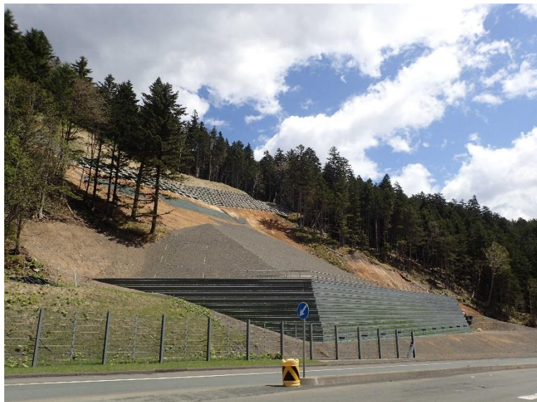
富士地区5 治山工事 北海道北見市
