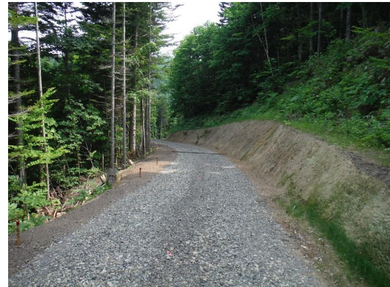
上古丹3号沢支線林道（林業専用道）新設工事 北海道紋別市
