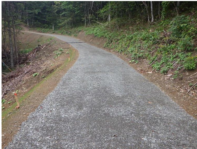
峠下左股（林業専用道）新設工事 北海道湧別町
