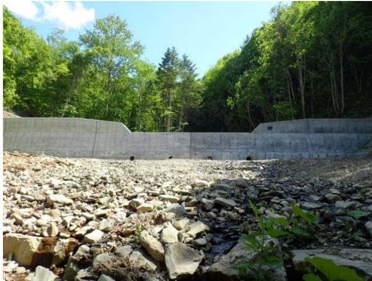
野上の沢治山工事 北海道遠軽町 〈林道工事〉
