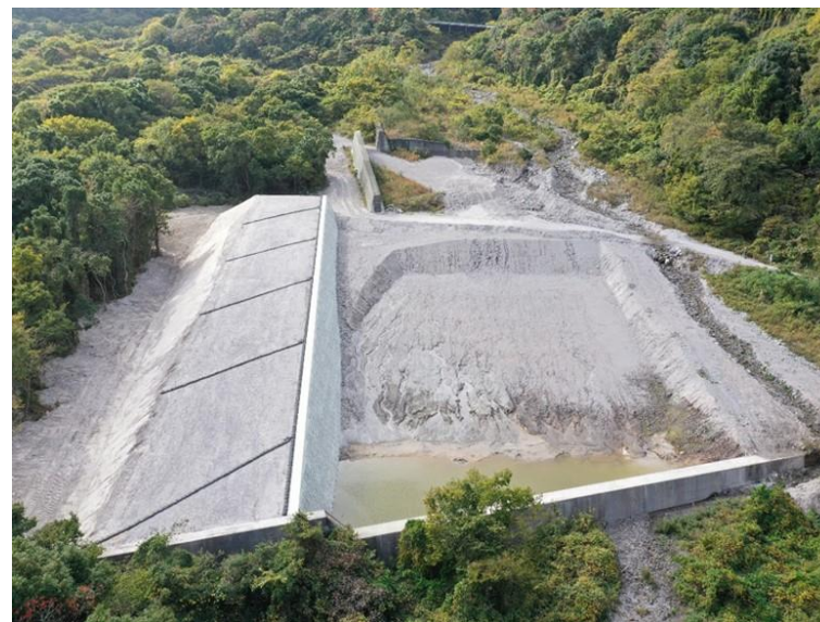
島原温泉岳治山工事（3溪） 長崎県島原市
