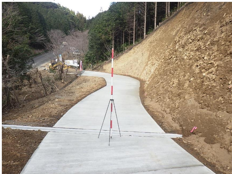
池之河原林道大平支線新設工事 宮崎県串間市
