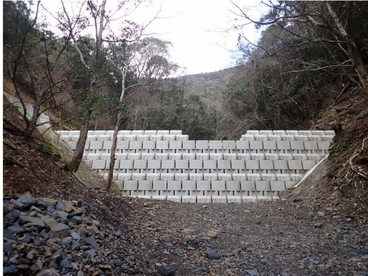
柚園治山工事（関連災）
