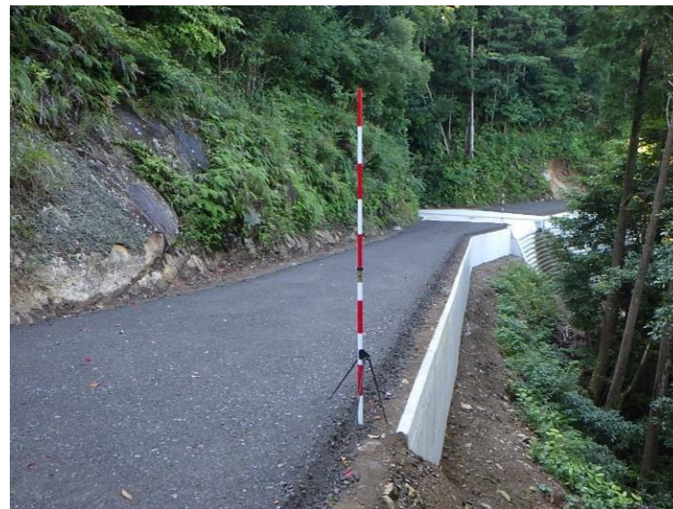
高野52林道新設工事 鹿児島県肝付町
