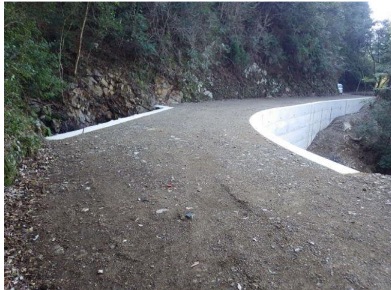
勝間林道55支線改良工事（明許）
