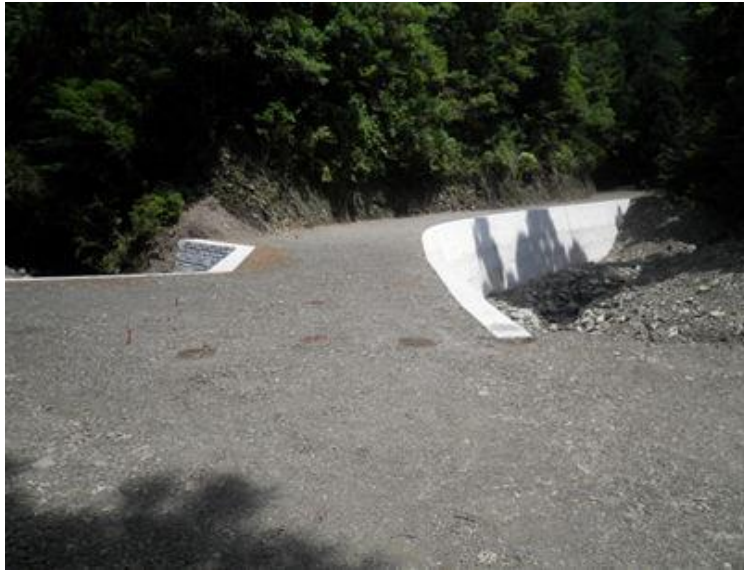
芳川林道災害復旧工事（翌償） 高知県四万十町
