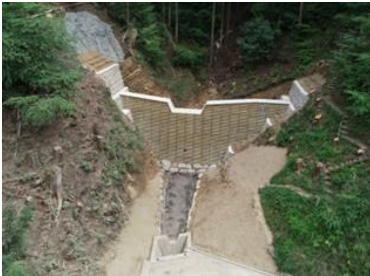
朝日出山(2201)災害関連緊急工事(翌債) 高知県馬路村 湯浅建設(株)
