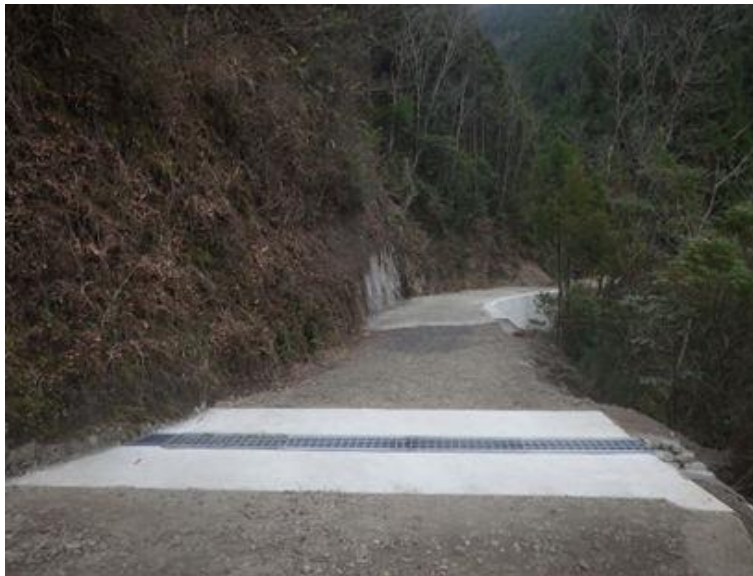
亀谷林道災害復旧工事（明許） 高知県馬路村
