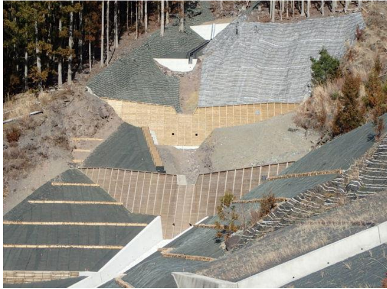
阿津江地区阿津江（下）地すべり防止工事（明許） 〈林道工事〉
