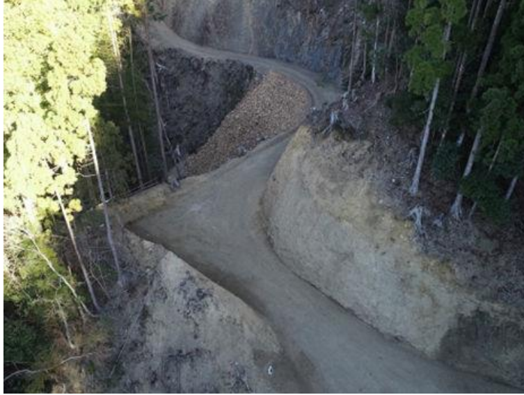
長滝林業専用道新設工事（翌債）
