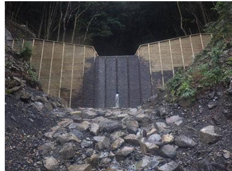
大森山(1203)復旧治山工事 (明許) 高知県三原村
