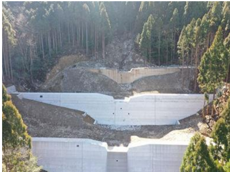
笹郷山(2015)復旧治山工事 (明許) 愛媛県宇和島市
