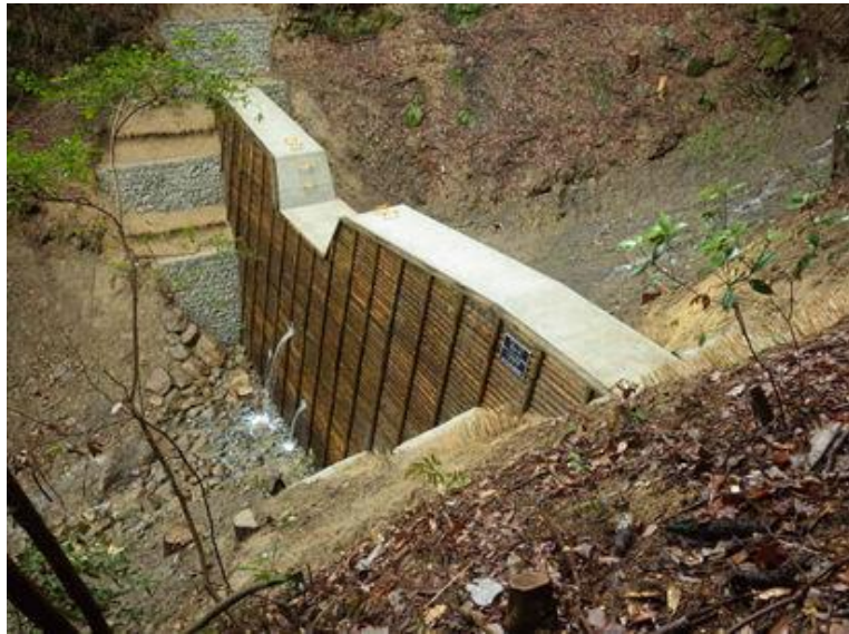
滝山(45)復旧治山工事 (明許) 香川県まんのう町
