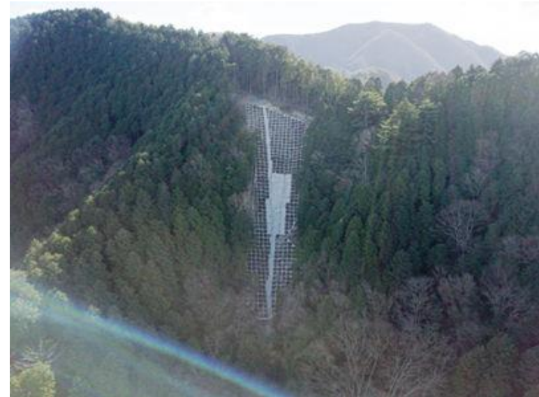
中尾(13)復旧治山工事 香川県東かがわ市
