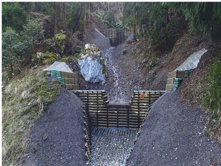
杉山溪間工事 滋賀県高島市
