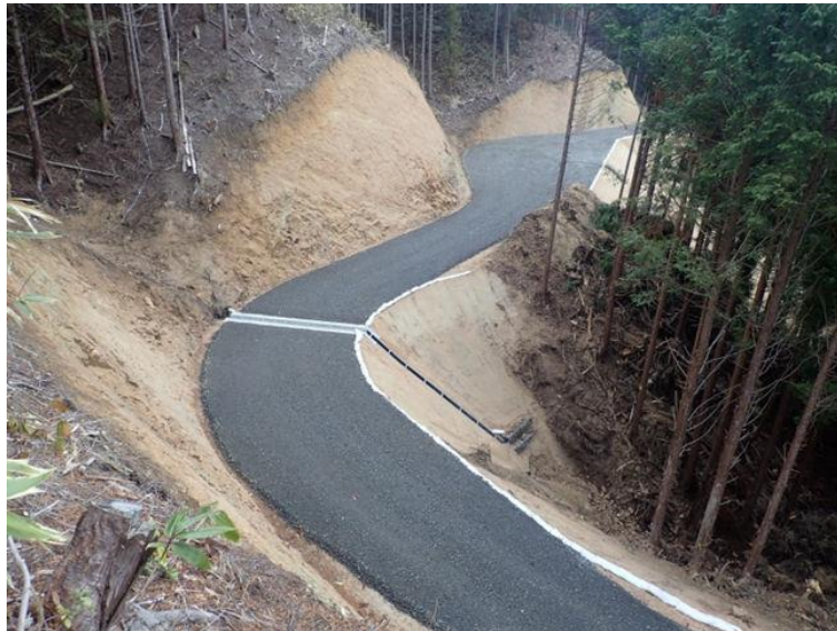
土屋山森林作業道新設工事 鳥取県日南町
