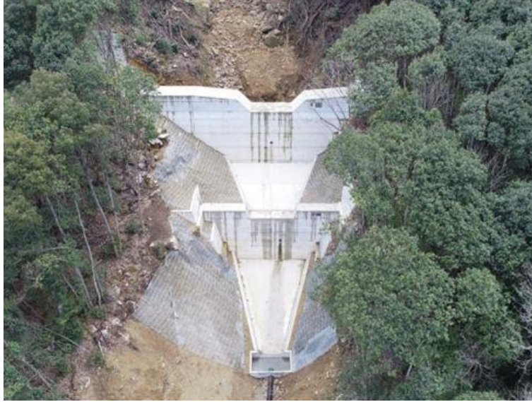
用倉山災害復旧工事 広島県三原市 〈林道工事〉
