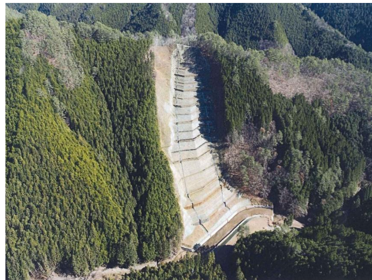
檜股山腹工事 (ゼロ国債) 奈良県野追川村
