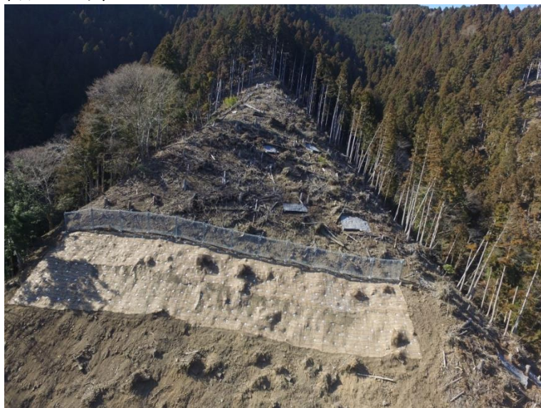
貴船山山腹工事
