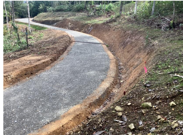
鷹泊支線林道（林業専用道）新設工事 北海道深川市
