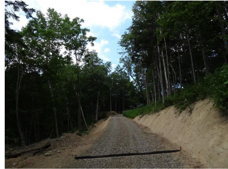
岩山林道（林業専用道）新設工事 北海道美瑛町
