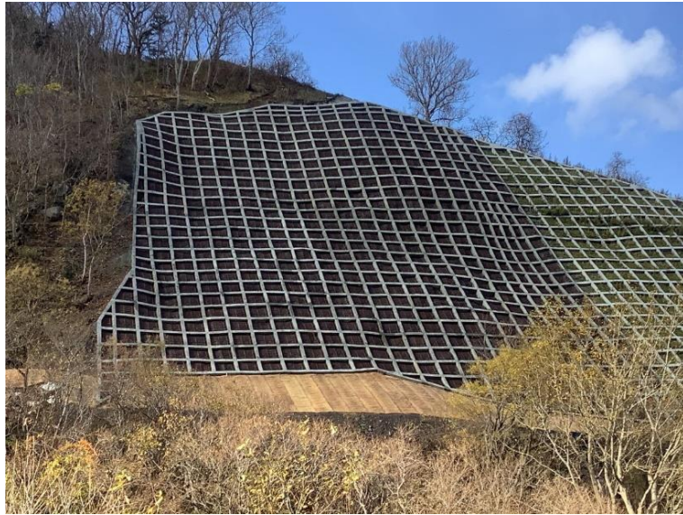
リヤウシナイ川治山工事 北海道利尻富士町
