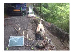
6月11日、路肩崩壊箇所への大型土嚢の設置作業
