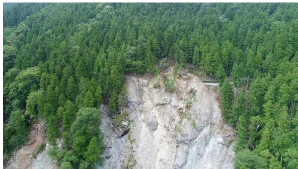
ドローンで撮影された被害状況（横佐古山）
