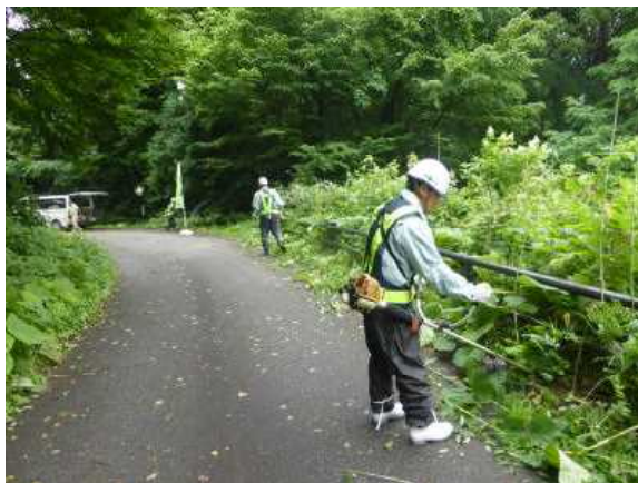
刈払い機での除草作業
