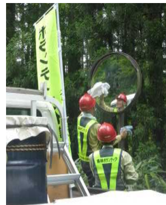
カーブミラーの清掃作業
