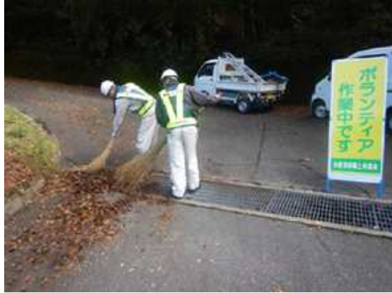
路面と横断溝の清掃
