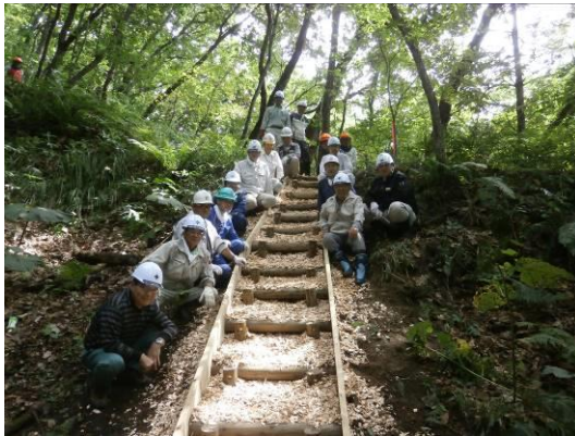
土砂とチップを投入して完成
