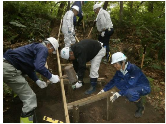
新しい資材で木製階段を修理
