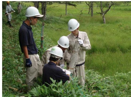
腐朽した杭の取替作業
