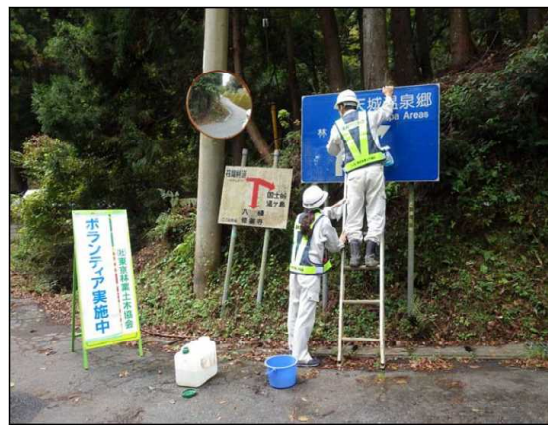
道路標識の清掃
