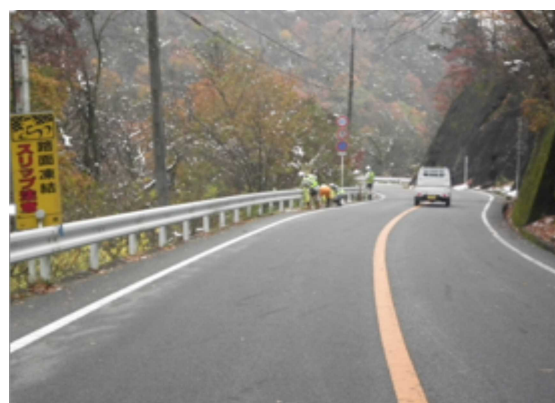
作業状況の遠景
