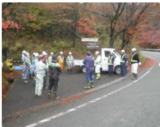
作業前のミーティング
