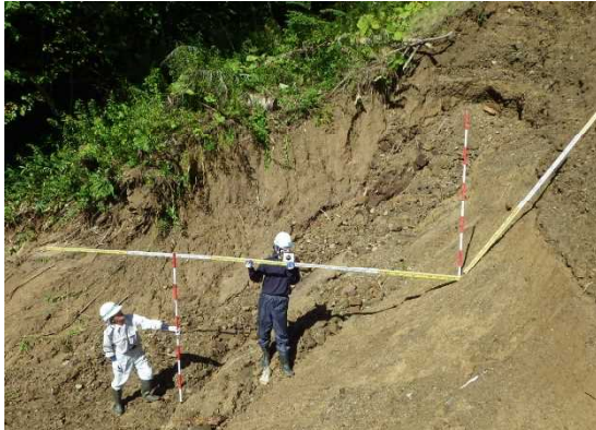
林道の法面崩壊（日高北部署管内）
