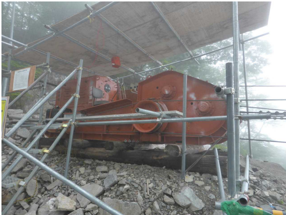
架線を使用する難しい施工条件
