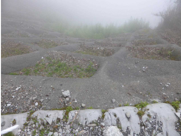
急勾配ののり面工事箇所（上から）
