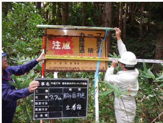
(腐食した注意標識)
