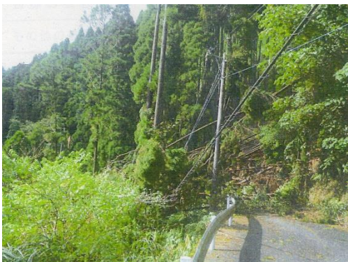
風倒木による電柱等の被害状況
