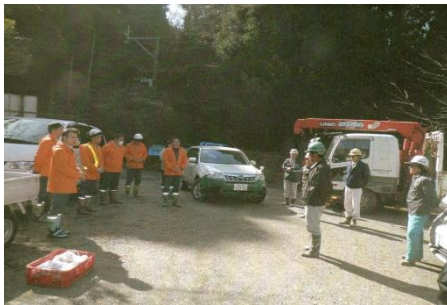
作業前のミーティング
