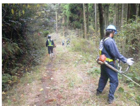
林道沿いの雑草木の刈払作業
