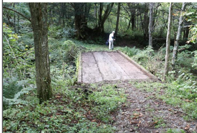
遊歩道橋清掃完了後
