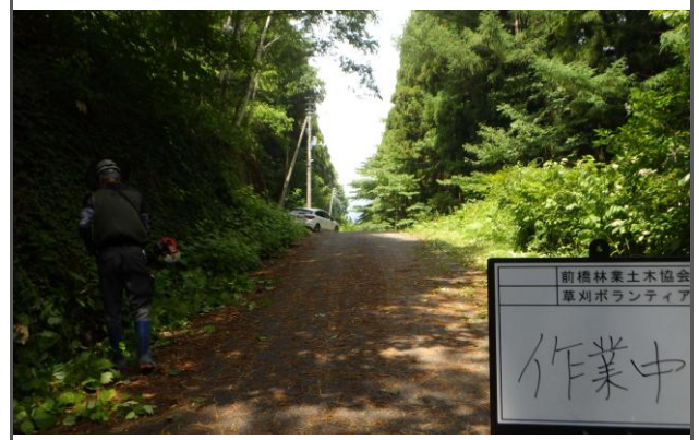
作業中の状況
