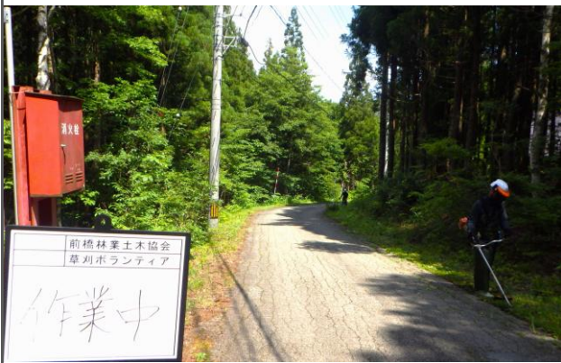
作業中の状況
