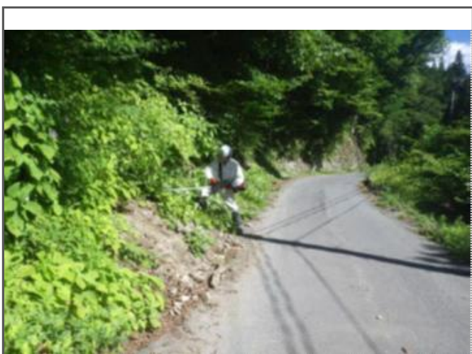
林道沿線の作業の様子
