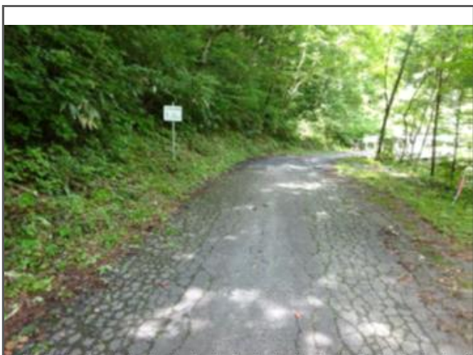
作業完了後の様子
