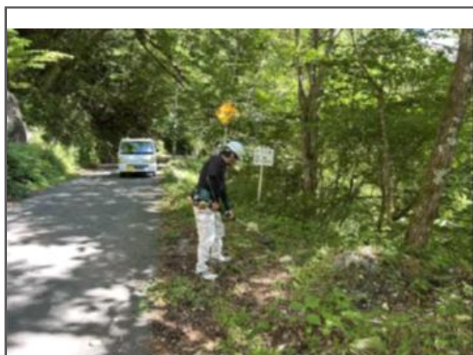
林道沿線の作業の様子
