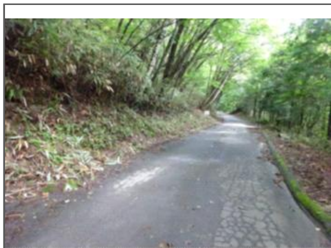
作業完了後の様子
