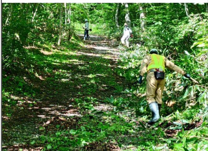
遊歩道へ通じる林道の整備
