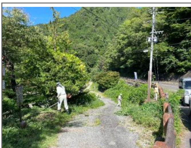
溪谷への進入路の草刈作業
