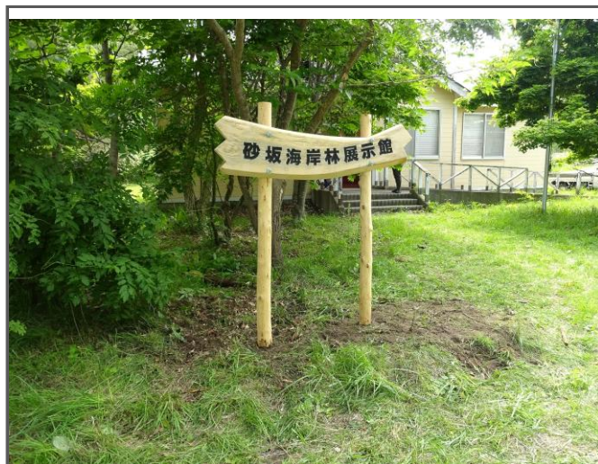
展示館看板建込み
