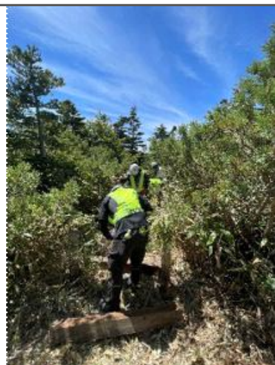
遊歩道撤去作業の様子
