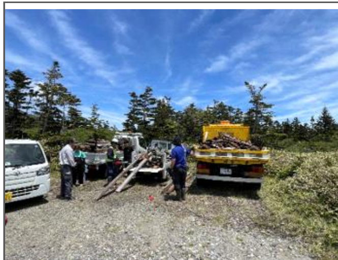
撤去した遊歩道資材
