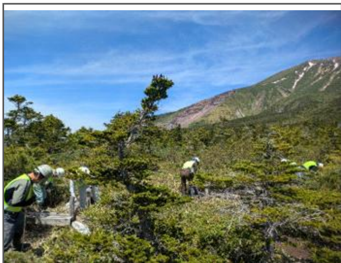
遊歩道撤去作業の様子
